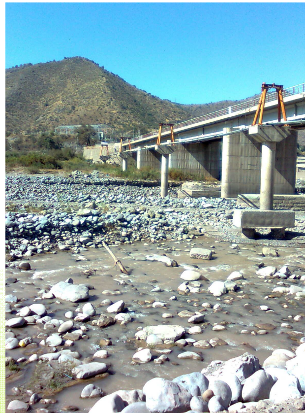
Estado Puente Los Morros, comuna de San Bernardo.
