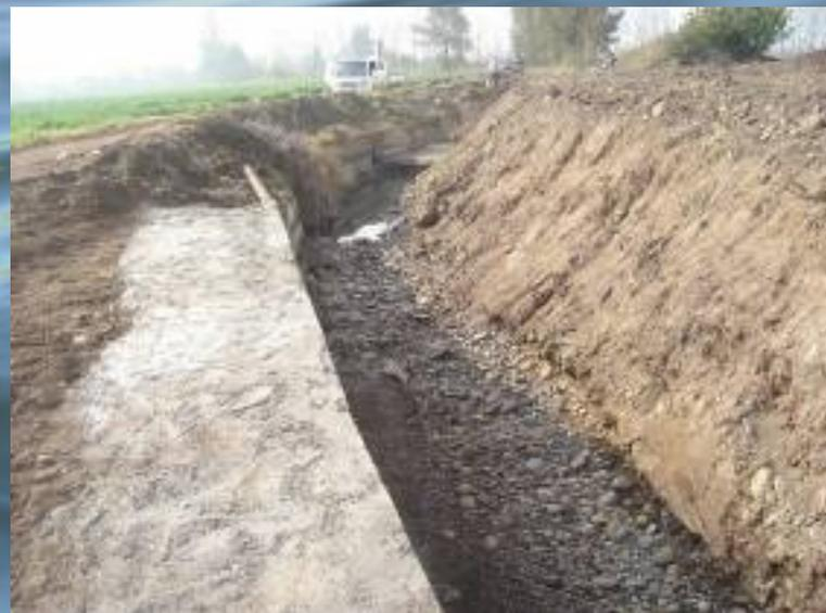
Gavión en borde de canal Unificado, sector Los Carvallo. Construcción realizada para evitar y contener socavación de borde derechos aguas abajo, como resultado de la velocidad de flujo en el sector y el tipo de suelo.
