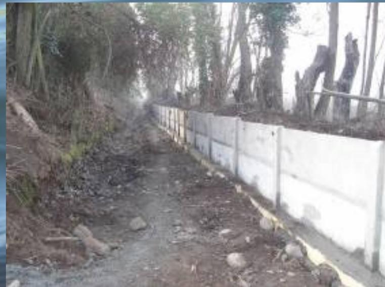
Muro en sector de Tracy en canal Calera. Obra realizada para detener filtraciones y derrumbes, evitando desborde a propiedad y plantaciones que se encuentran bajo nivel del canal.
