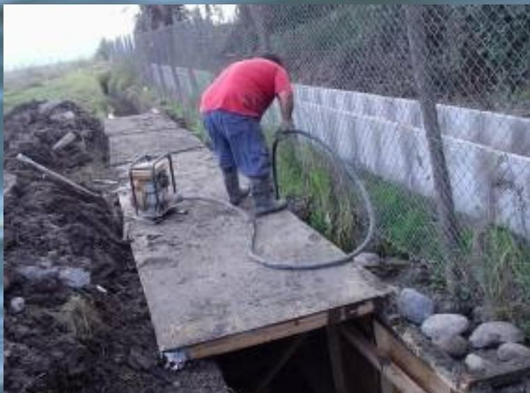
Reparación muro canal Délano, en sector El Acacio. El objetivo fue reforzar muros y detener filtración.
