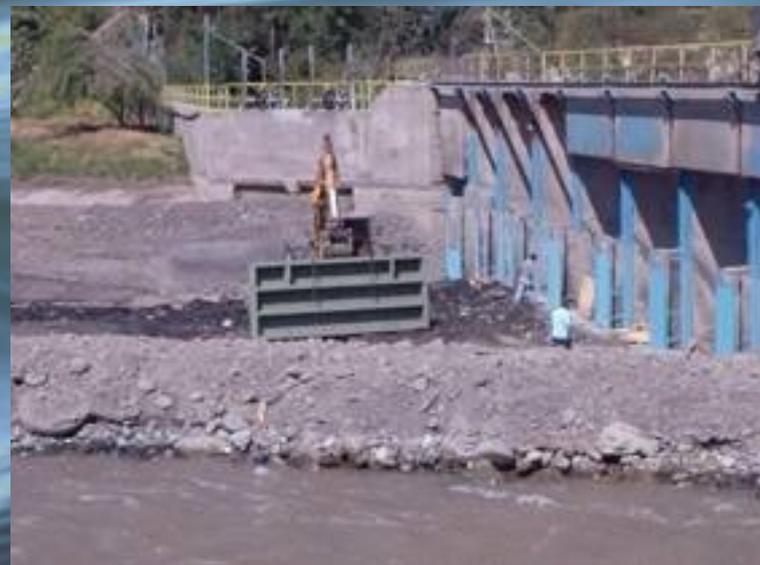
Construcción e instalación compuertas de Bocatoma. Continuando con el programa de mantención y mejoramiento, en esta temporada fueron cambiadas tres compuertas nuevas.
