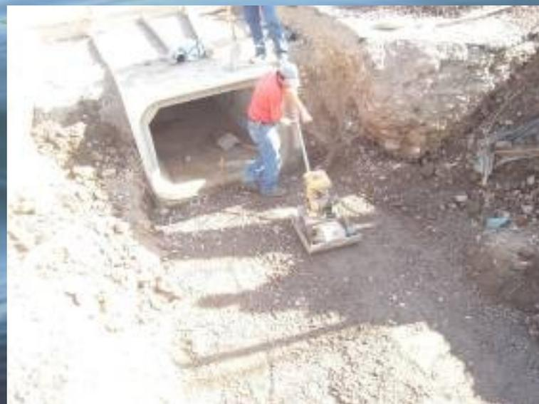
Cruce canal Santa Marta en camino Las Margaritas, San Bernardo. Cambio de cruce de una tubería de cemento comprimido de diámetro 600 mm, a una un cajón de hormigón prefabricado de dimensiones 1,2x1,0 m.
