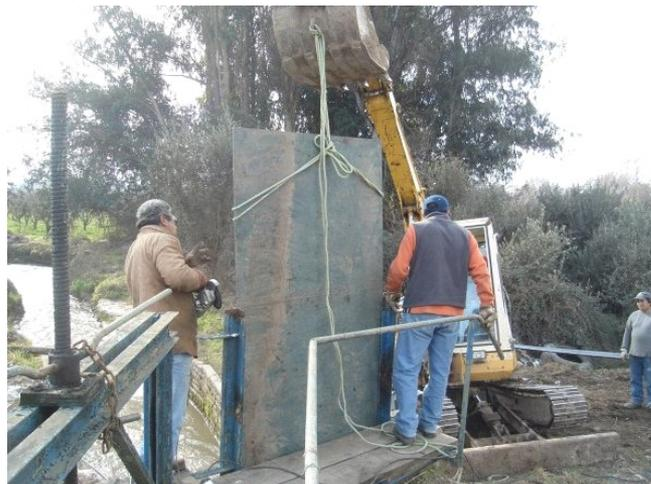
Reparación e instalación compuerta canal Santa Cruz en marco partidor 066, sector Tres Acequias.
