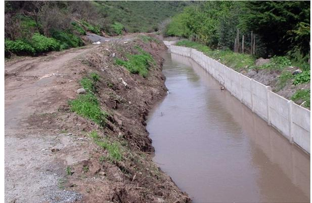
Muro en sector cerro en canal Calera (antes y después de obra ). Esta fue construida para detener filtraciones y evitar derrumbes.
