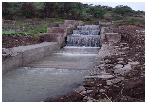
Caída Tracy antes y después de la obra. Esta fue reparada para reforzar muros y taludes, detener filtraciones y mejorar la disipación de energía del agua en el canal Calera.
