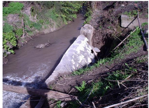
Potrero Los Conejos, en este punto se construyó un muro para reparar la rotura del borde del canal Capilla Santa Cruz.
