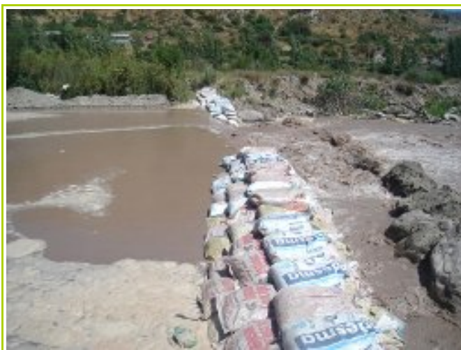
Banco Desarenador Bocatoma
