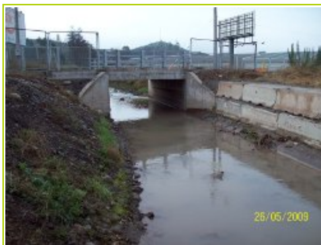
Puente en Canal Calera costado Autopista Central, comuna San Bernardo.
