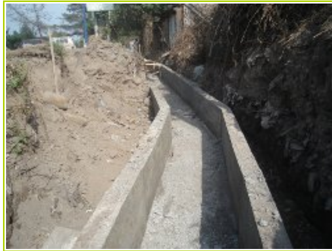
Revestimiento de canal desagüe Tracy, comuna San Bernardo.
