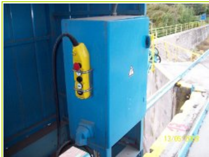
Automatización Carros Compuertas
