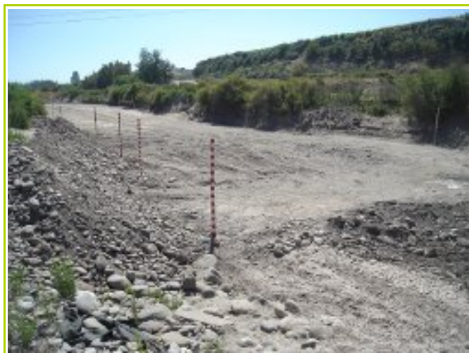
Banco Desarenador Bocatoma
