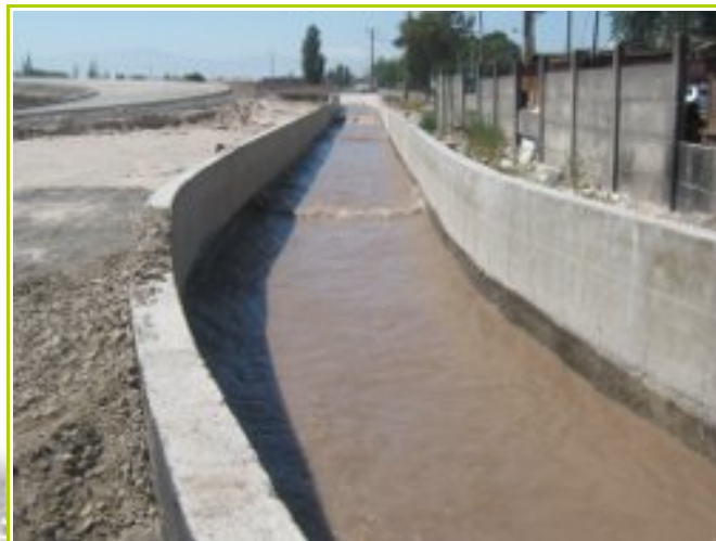
Revestimiento de canal Tagle-Gandarilla, comuna de Maipú
