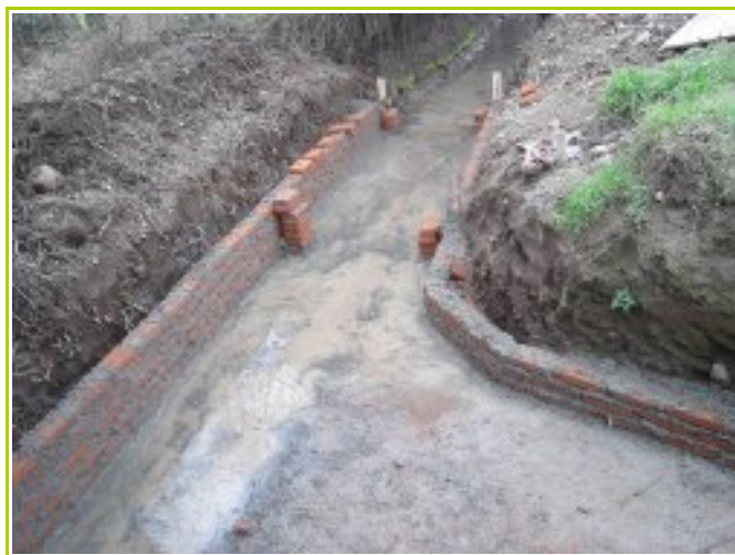
Diseño y construcción de marco partidor Megáridos, comuna San Bernardo.
