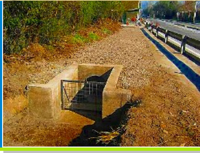
Entubamiento de 60 metros del canal San Javier, frente a Cementerio Parque Padre Hurtado. Peñaflor.
