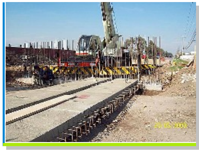
Construcción de nuevo puente sobre canal Espejo en calle Santa Marta. Maipú.
