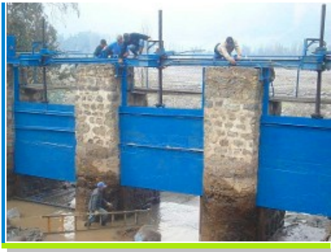
Mantención compuertas descarga a río Maipo en Canal Tronco.
