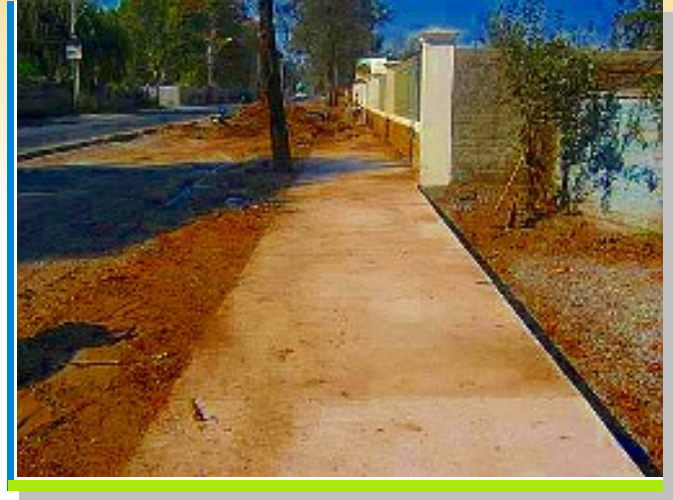
Abovedamiento de 280 metros de canal Chambeo en Conjunto Santa Filomena de Nos. Comuna San Bernardo.
