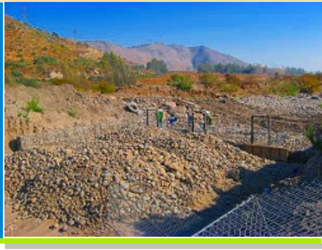
Construcción barrera contención desarenador.
