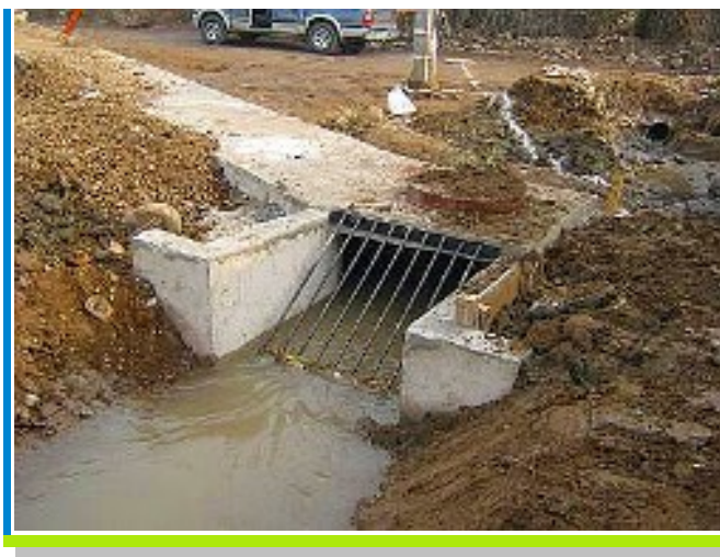
Abovedamiento de 400 metros del canal Miraflores en Cd Ripley. San Bernardo.
