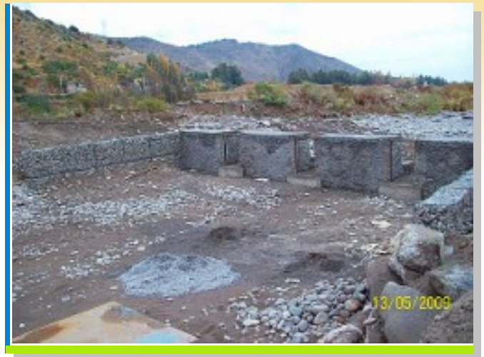
Construcción barrera contención desarenador.
