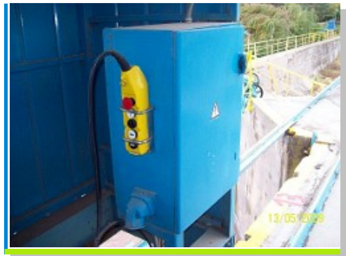
Automatización compuertas carro compuertas.
