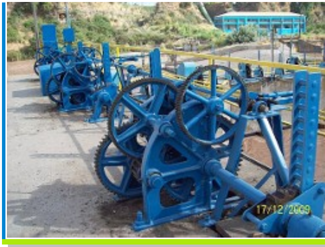
Mantenimiento sistema de compuertas Bocatoma.
