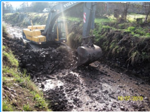
Canal Espejo, sector Calle Costanera, Comuna de San Bernardo.
