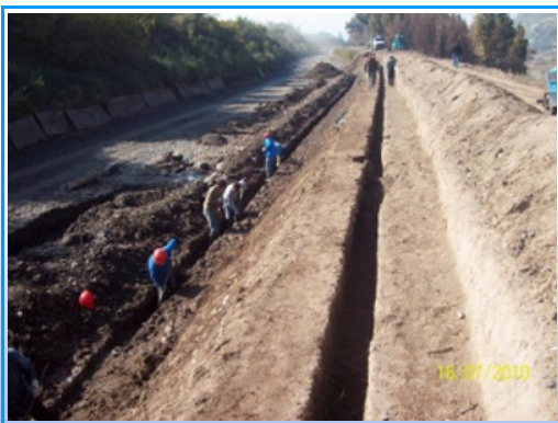
Excavación y preparación del terreno.
