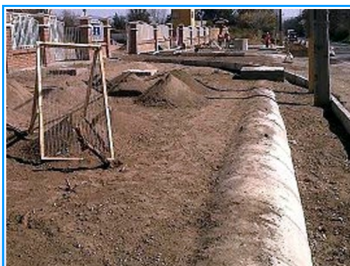
Entubamiento de 250 metros (tres canales), frente a Colegio San Andres. Calera de Tango.
