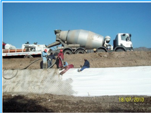
Llenado con mortero del Filter Point Matt.
