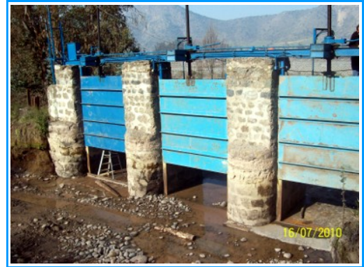
Reemplazo compuertas Canal Tronco de descarga a Río Maipo.
