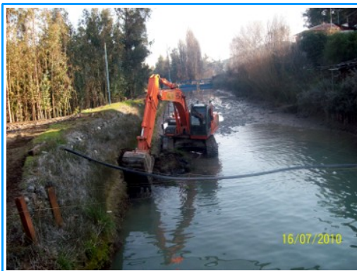
Limpeza de Canal Tronco aguas arriba de Marco Partidor Espejo/Unificado.
