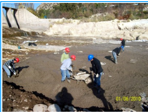
Reparación losa Bocatoma El Clarillo.
