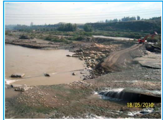
Reparación losa Bocatoma El Clarillo.
