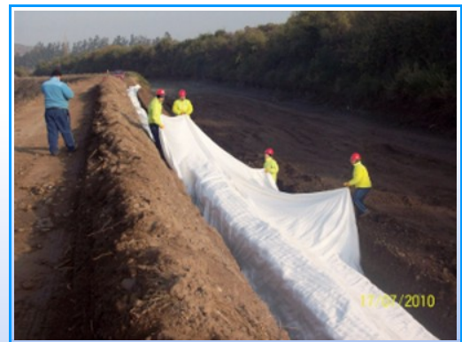
Instalación del Filter Point Matt.
