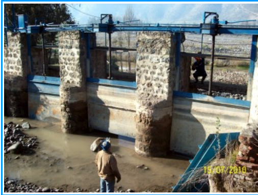
Reemplazo compuertas Canal Tronco de descarga a Río Maipo.
