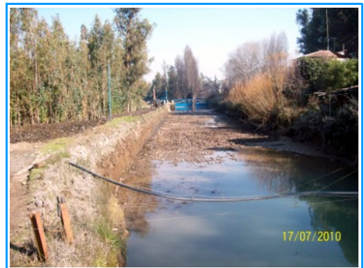
Limpeza de Canal Tronco aguas arriba de Marco Partidor Espejo/Unificado.
