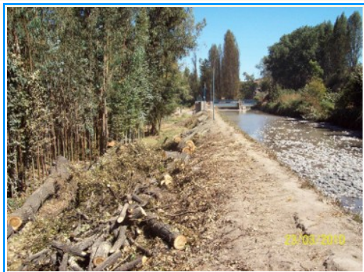
Talud sur Canal Tronco, despeje talud antes del relleno compactado.
