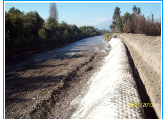
Inicio flujo de agua en Canal Tronco.
