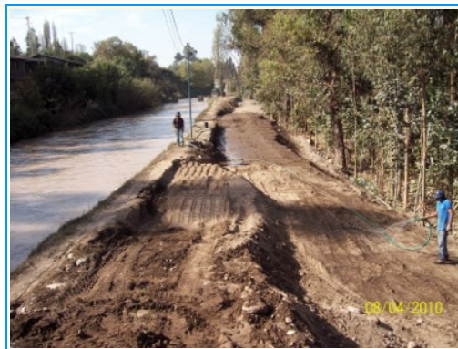
Proceso de relleno.
