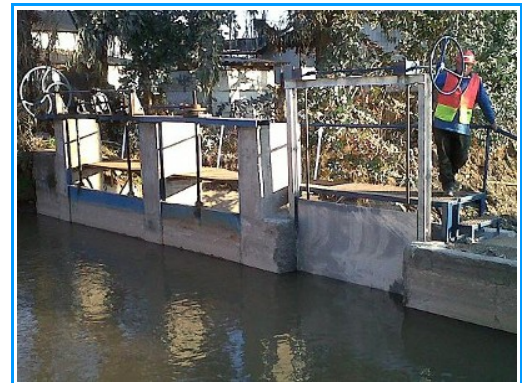
Compra e instalación de compuerta galvanizada en descarga de canal Espejo a Santa Marta. Maipú.
