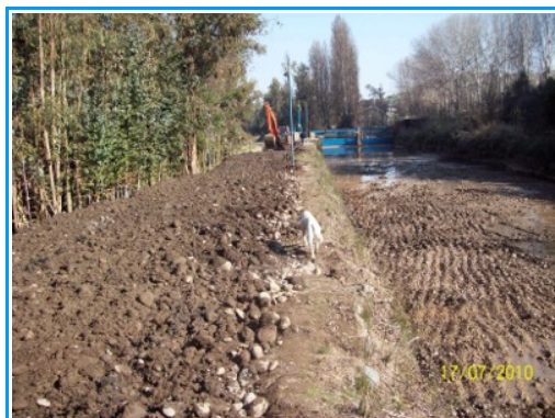
Talud sur Canal Tronco, refuerzo con relleno compactado.
