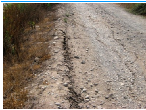
Grietas borde Canal Tronco después de Terremoto.
