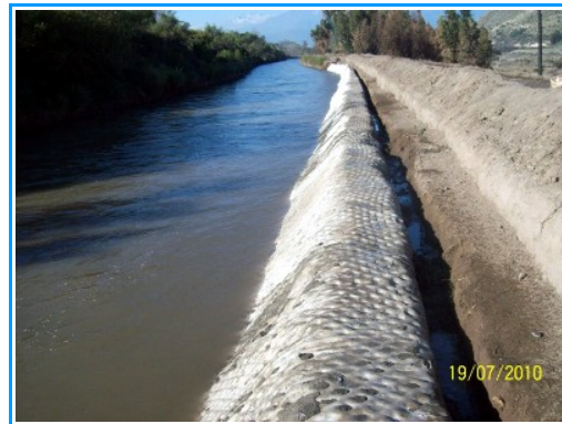
Canal Tronco en funcionamiento.
