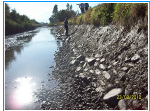
Inspección dentro del Canal Tronco.
