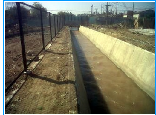
Foto1 y 2: Antes y después del revestimiento del canal Santa Cruz. Comuna Padre Hurtado.
