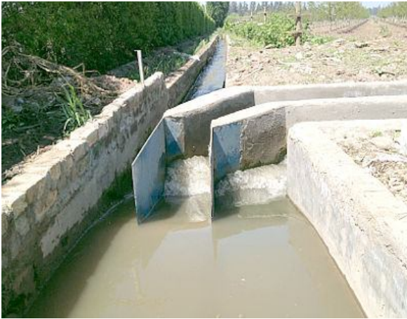
Fotos 11 y 12: Antes y después de construcción de marco partidor en Fundo el Sauce. Calera de Tango:
