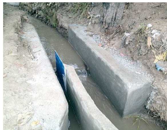
Fotos 7 y 8: Antes y después de construcción de marcos partidores en Melón Áridos. San Bernardo:
