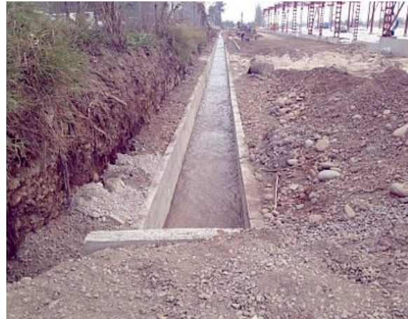
Fotos 1 y 2: Antes y después del revestimiento del Canal Santa Marta. Centro de Bodegas Simpson. San Bernardo:
