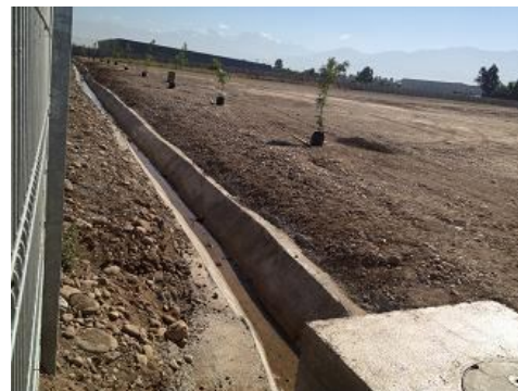
Fotos 19 y 20: Antes y después de revestimiento en Centro de Distribución Empresa CCU. San Bernardo:
