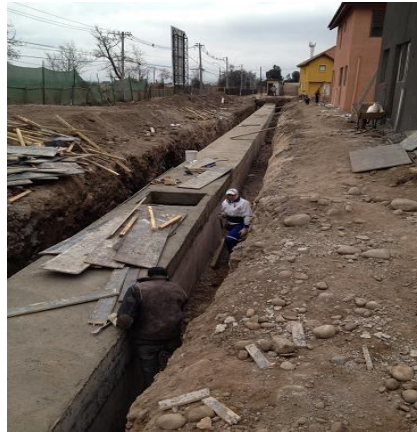
Fotos 16: Obras de abovedamiento en Portal del Bosque Poniente. Maipo:
