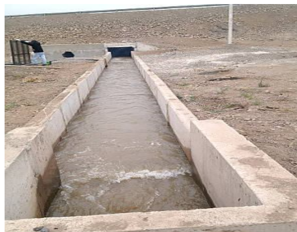
Fotos 3 y 4: Antes y después del revestimiento del Ramal Seminario en Peaje Padre Hurtado. Comuna Padre Hurtado:
