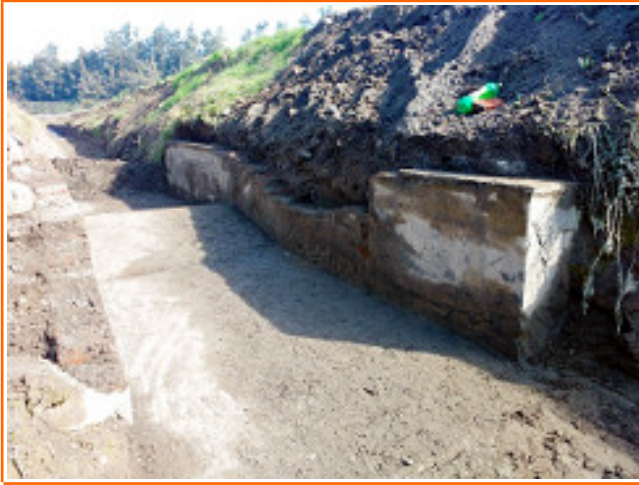
Canal Ochagavía, reparación sección aforo, Comuna de San Bernardo.
