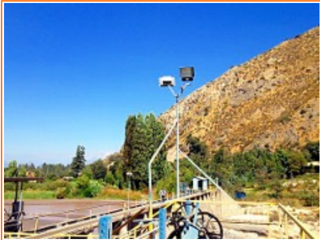
Reemplazo iluminación pasarela de maniobra compuertas frontales.
