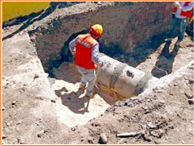
Revisión e inspección atravesos sanitarios bajo canales en acceso a Villa Las Aralias. Padre Hurtado.
