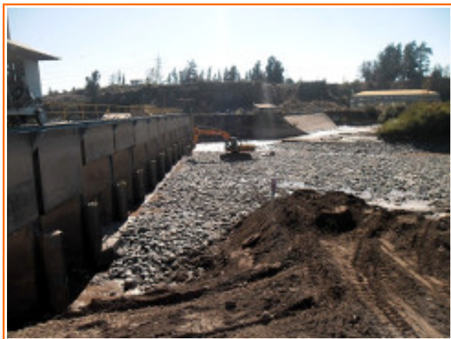
Construcción terraplén de acceso.
