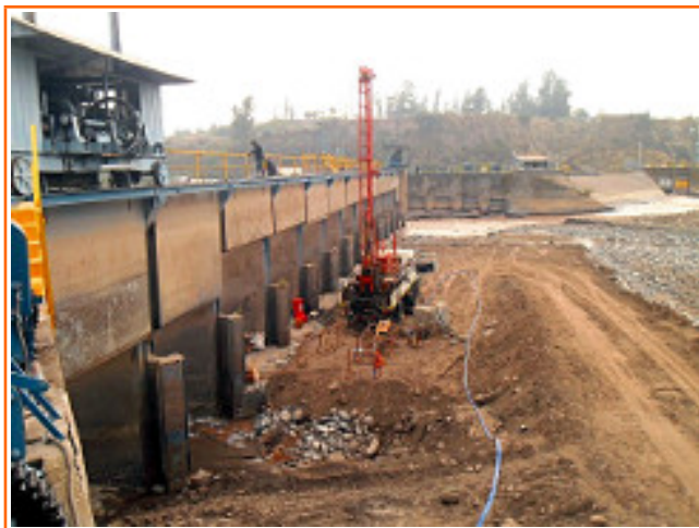
Maquinaria de prospección.
