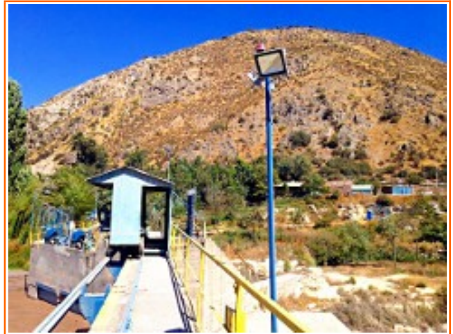
Reemplazo iluminación pasarela de maniobra compuertas frontales.
