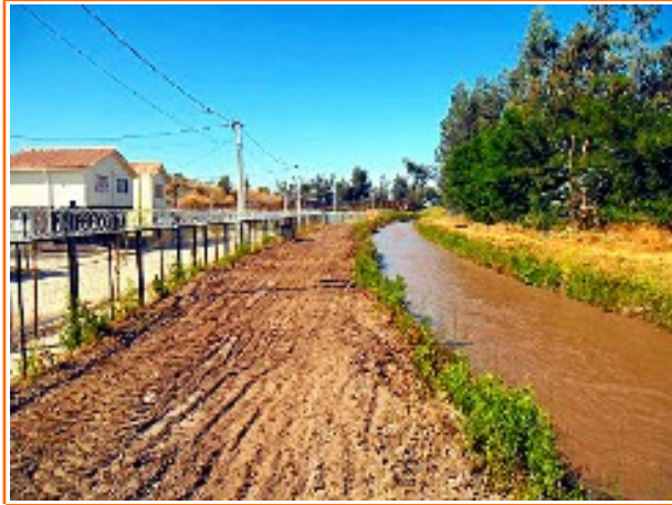
Canal Espejo, servidumbre costado de Conjunto Habitacional Aires Del Valle, Comuna de San Bernardo.
