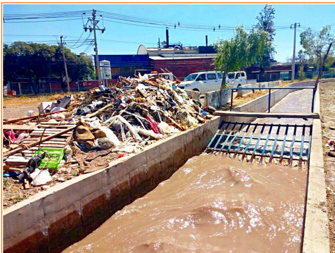
Reja contenedora de basuras Good Year, Canal Tagle Gandarilla, Comuna de Maipú.
