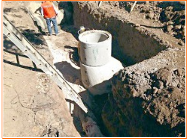
Revisión e inspección atravesos sanitarios bajo canales en acceso a Villa Las Aralias. Padre Hurtado.
