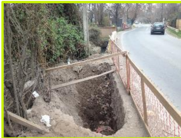
Trabajos Sector Camino El Barrancón
