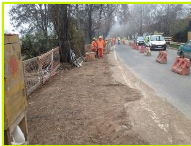
Trabajos Sector Canal Unificado
