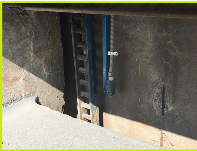
Instalación sensores finales de carrera.
