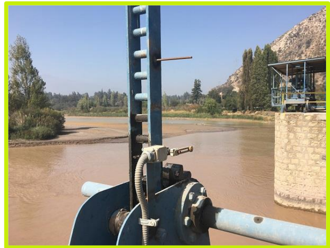
Instalación sensores finales de carrera.
