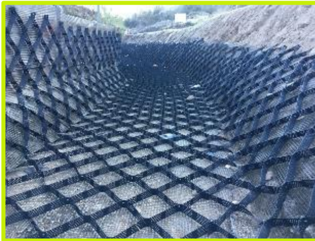
Colocación de la Malla
