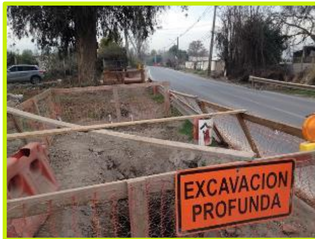
Trabajos Sector Camino El Barrancón
