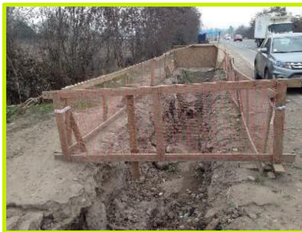
Trabajos Sector Av. Calera de Tango
