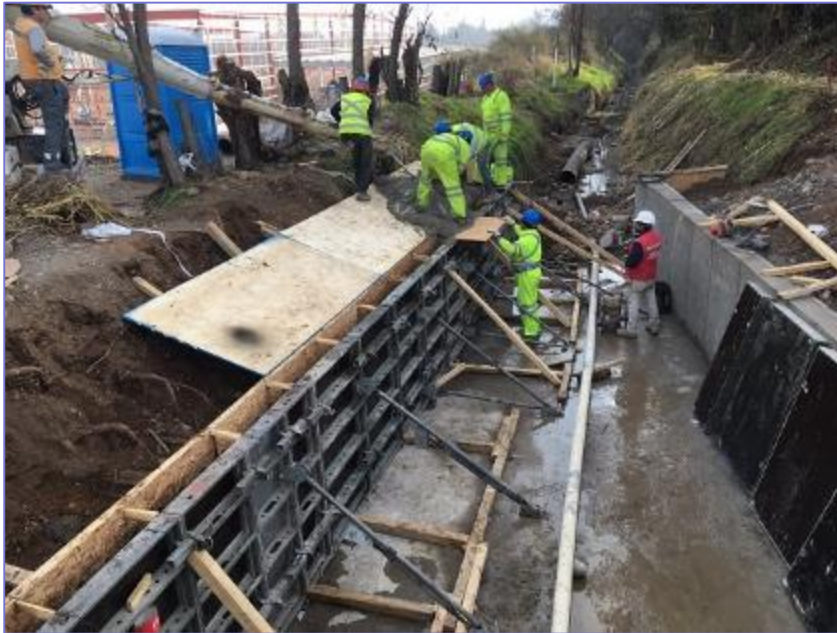
Proceso de construcción
