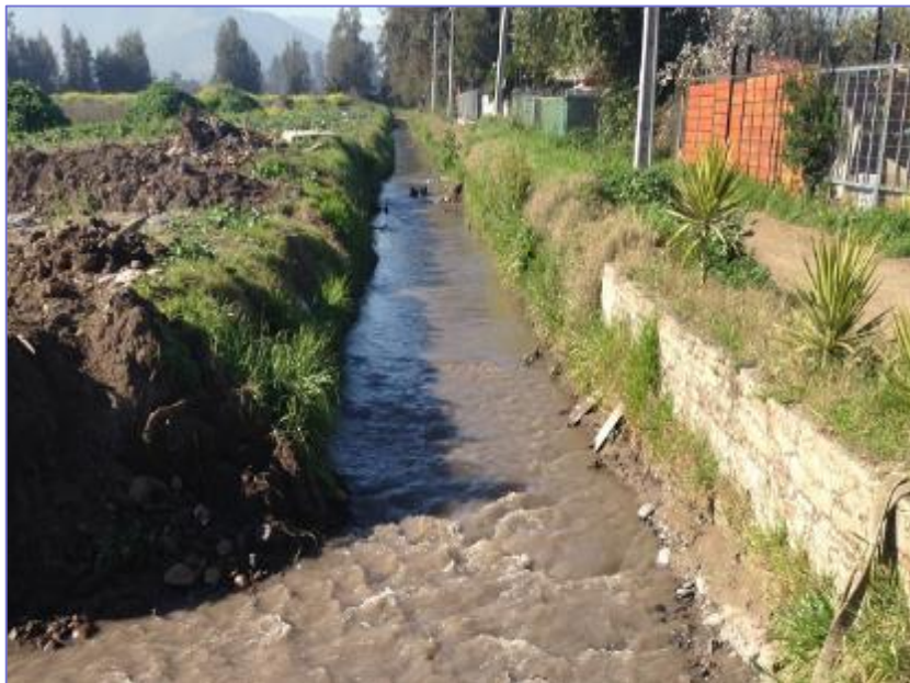
Condición actual Canal Calera
