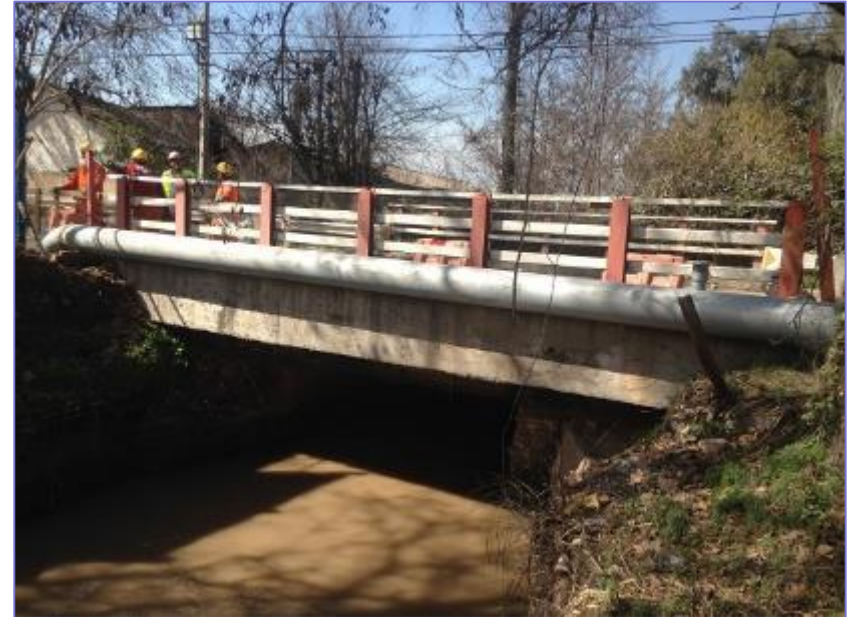
Cruce Alcantarillado sobre Canal San Vicente
