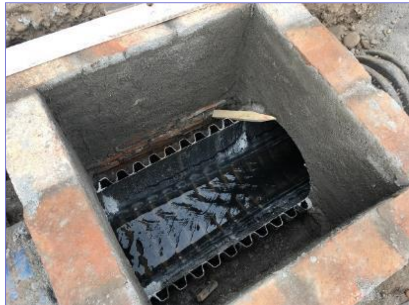
Cámara de inspección sin sedimentador
