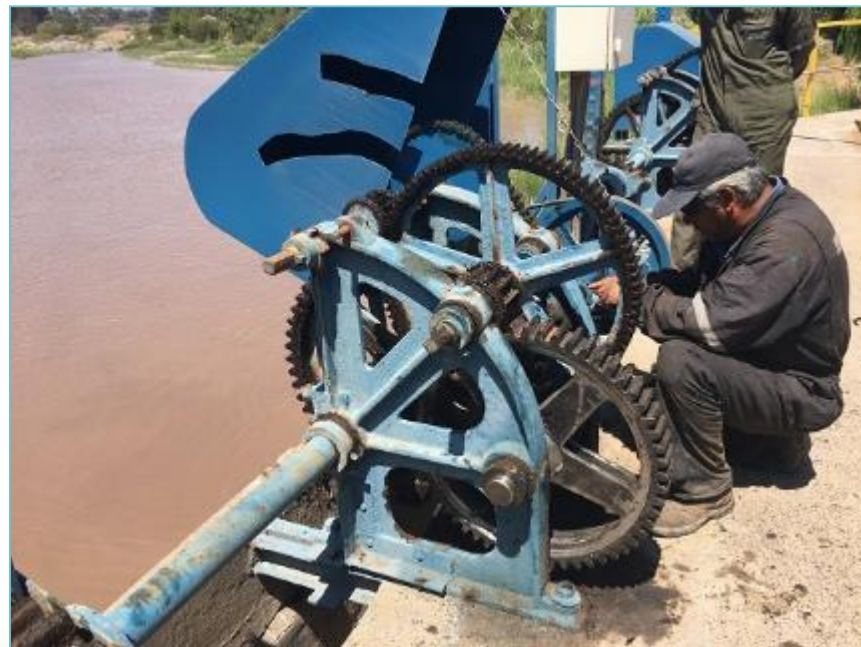
Reparación de engranaje compuerta N°1 canal Huidobro.
