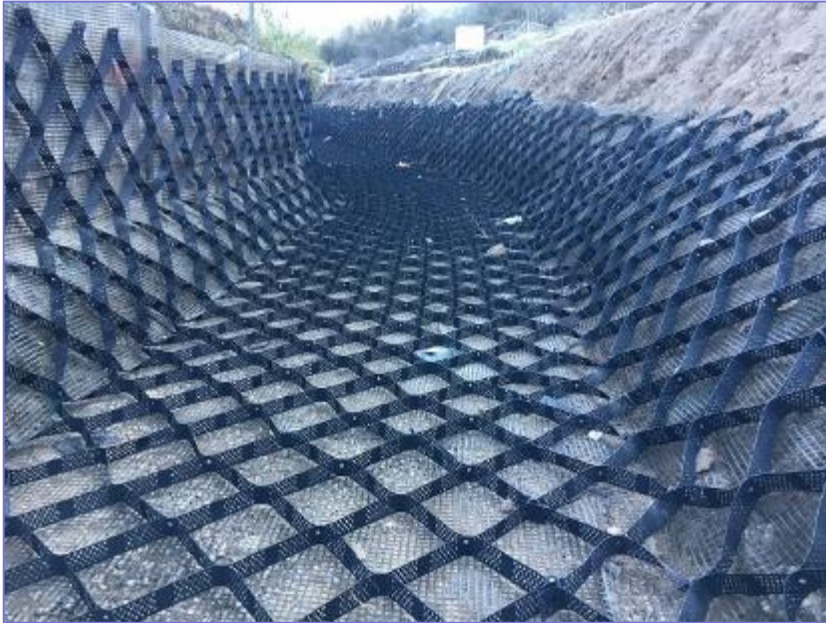
Instalación de Malla
