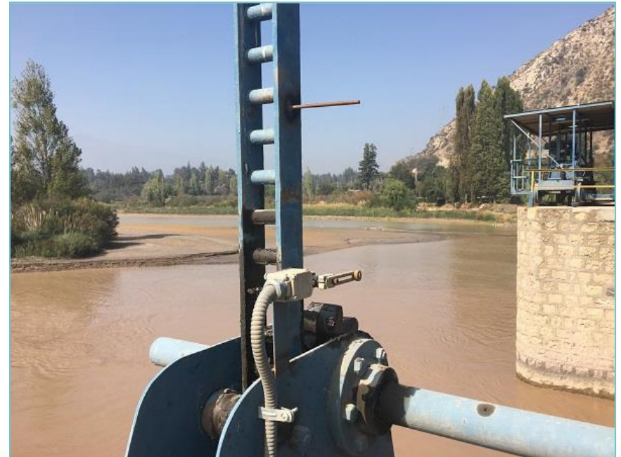
Instalación sensores finales de carrera.
