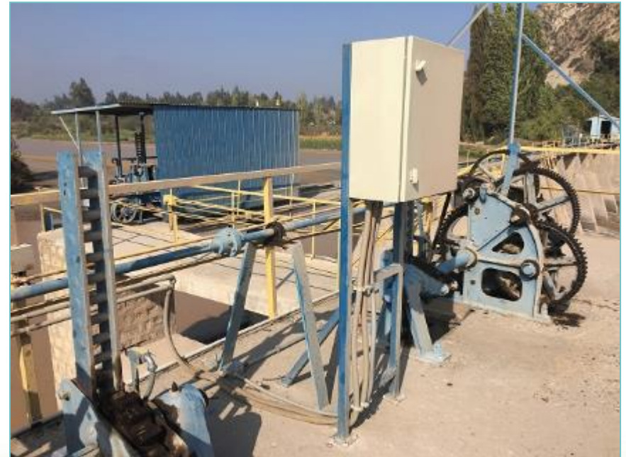
Instalación tablero de control compuertas altas.
