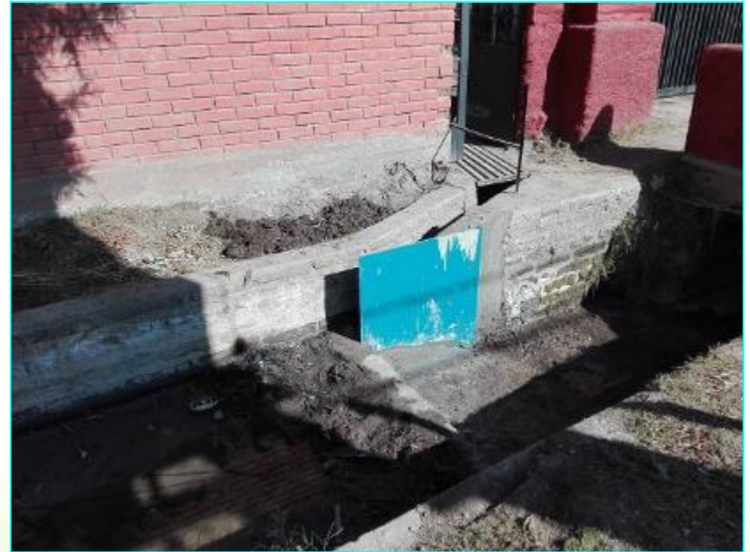
Canal San Javier, cambio punta partidora marco Porta Pía M127.
