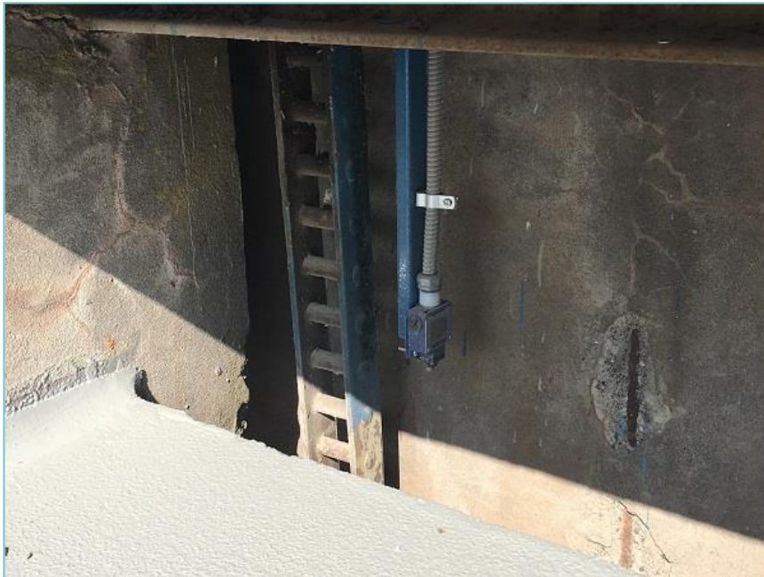
Instalación sensores finales de carrera.
