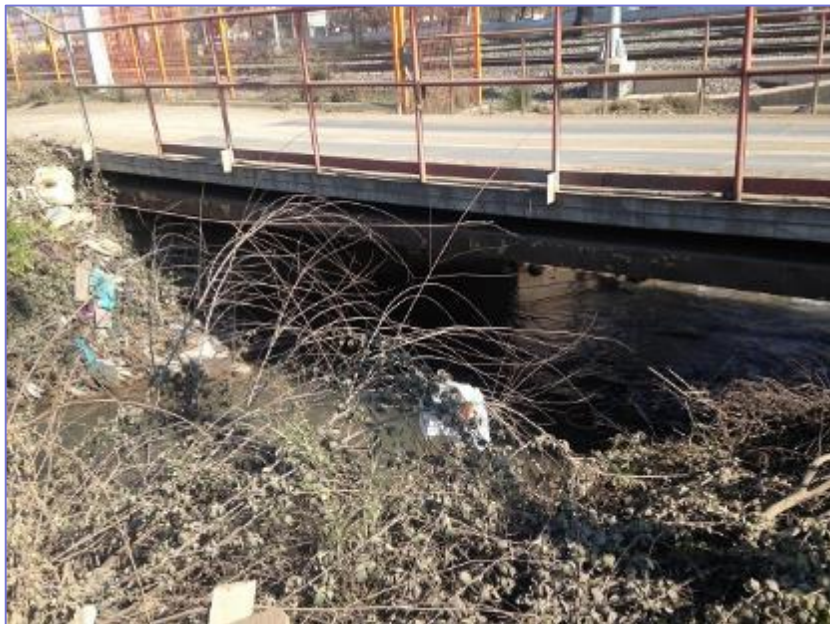
Emplazamiento cruce alcantarillado
