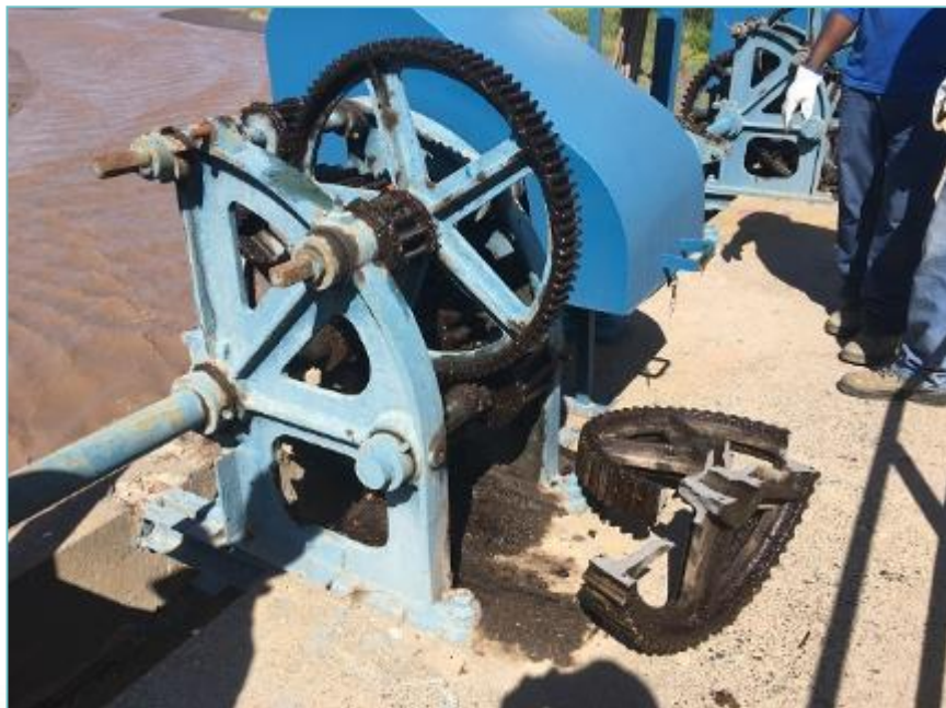
Reparación de engranaje compuerta N°1 canal Huidobro.
