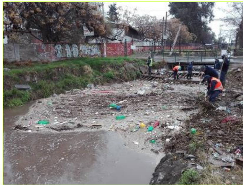
Limpieza reja contenedora de basuras en Canal Espejo, comuna de San Bernardo.
