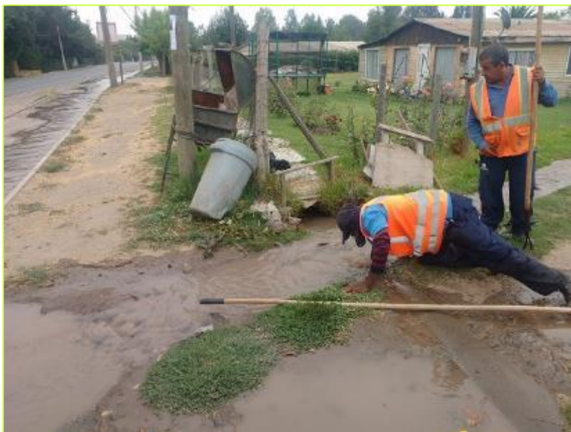
Limpieza canal particular por emergencia de desborde, comuna de Calera de Tango.
