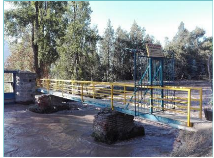
Construcción baranda de protección en pasarela.
