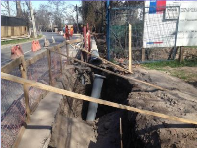
Trabajos sobre Canal San Vicente
