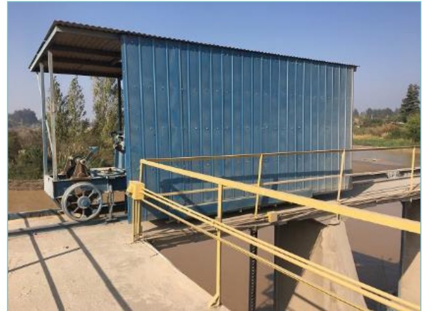
Cierre carro de maniobra N°1, compuertas frontales.
