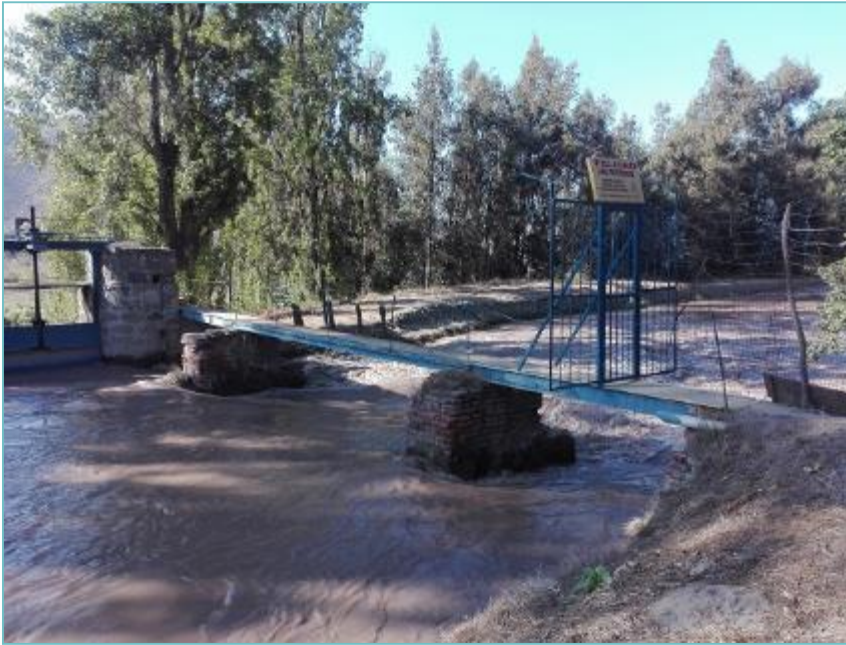
Construcción baranda de protección en pasarela.
