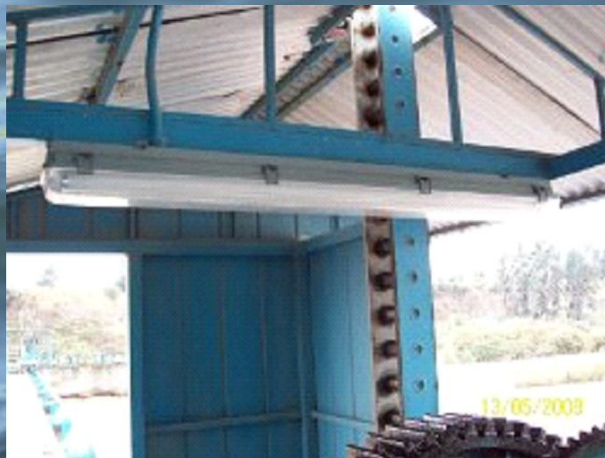
Iluminación Carros Compuertas
