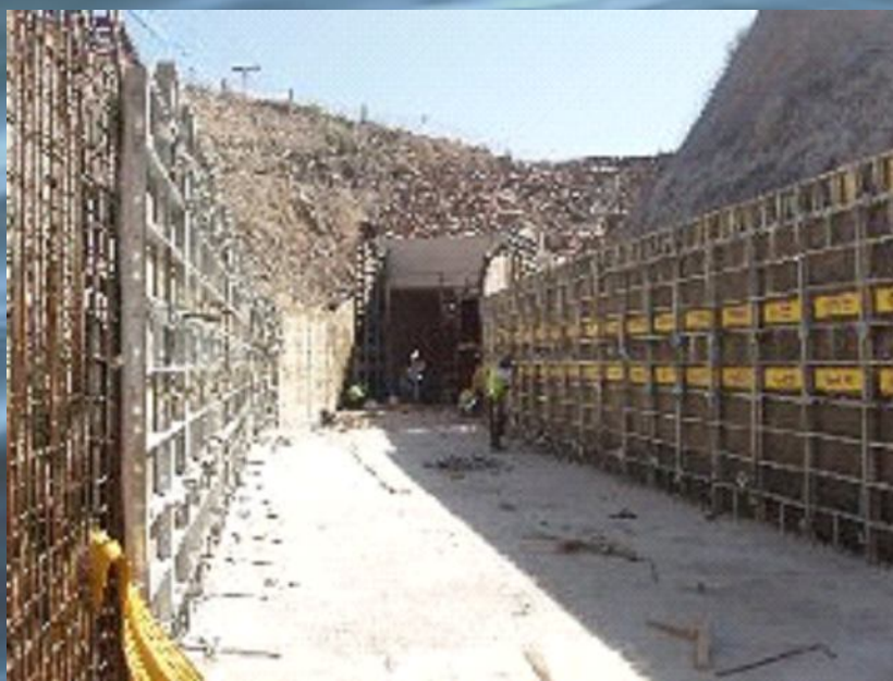
Obras en Canal Espejo.
