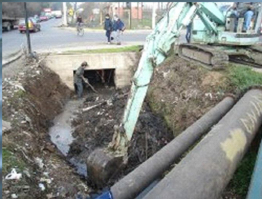
Limpieza y extracción de escombros, Canal San Javier
