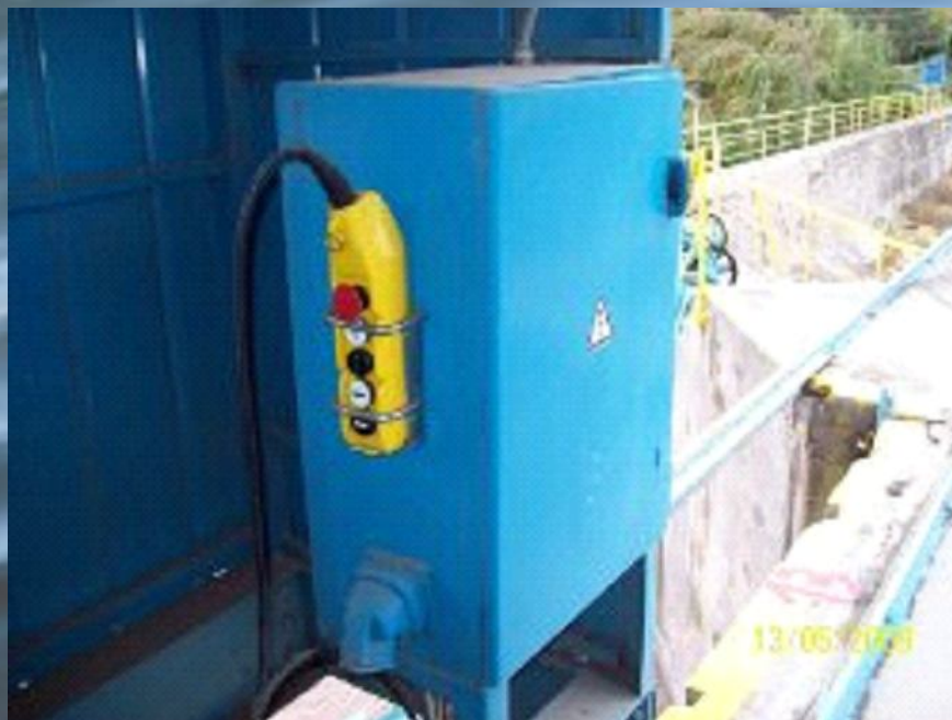
Automatización Carros Compuertas
