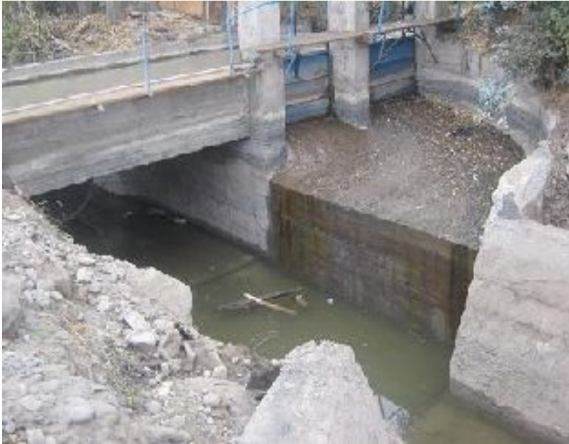
Foto 11 y 12: Compra e instalación de compuerta galvanizada en descarga de canal Espejo a Santa Marta. Maipú.
