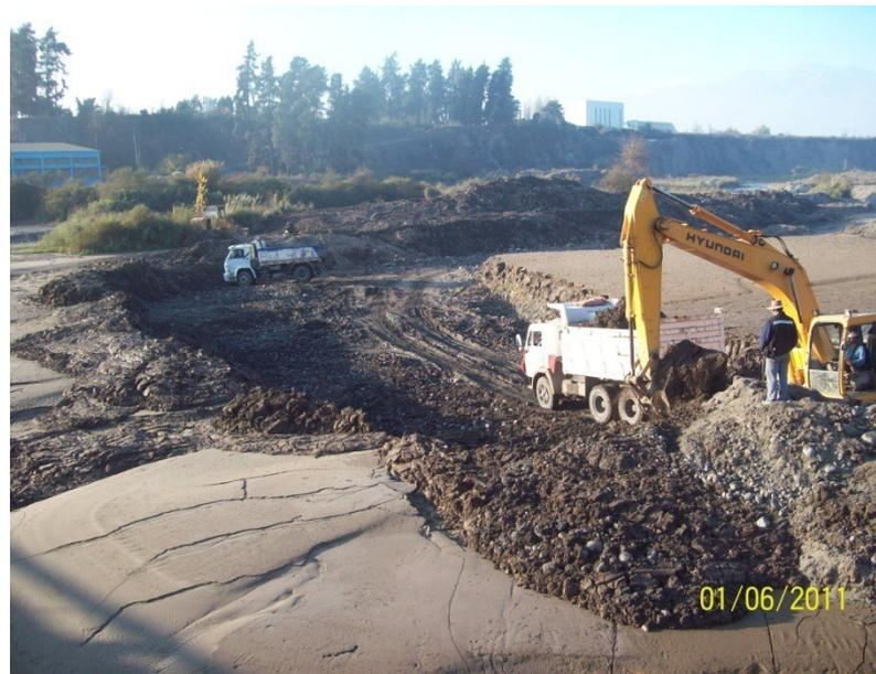
Mantenimiento aguas arriba compuerta río sector Bocatoma – Retiro Embanque.
