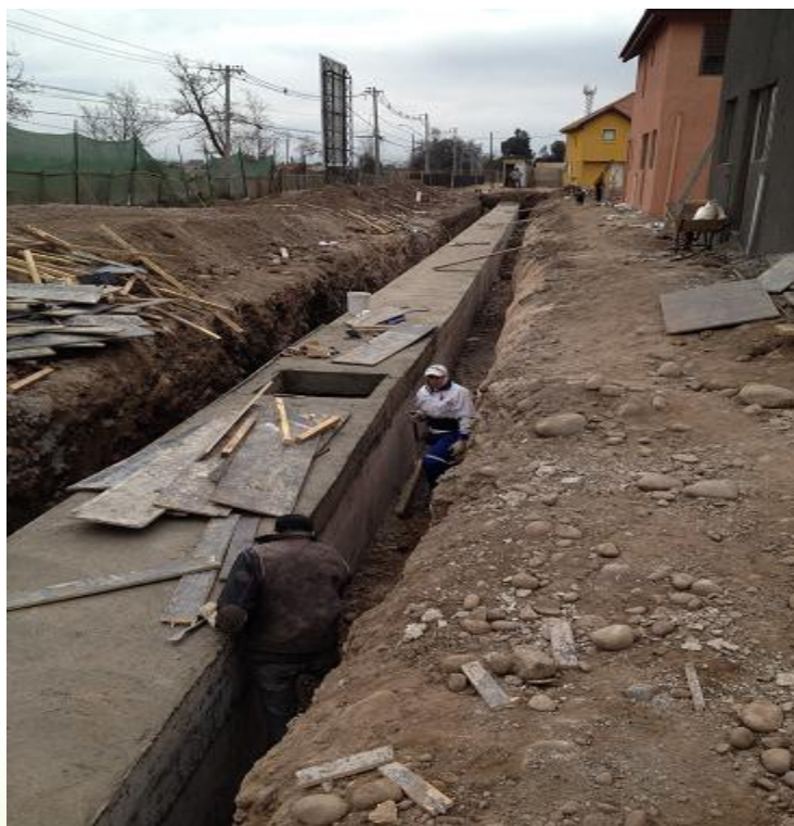
Abovedamiento Canal Deriva El Bosque, Loteo Portal del Bosque, Comuna de Maipú.
