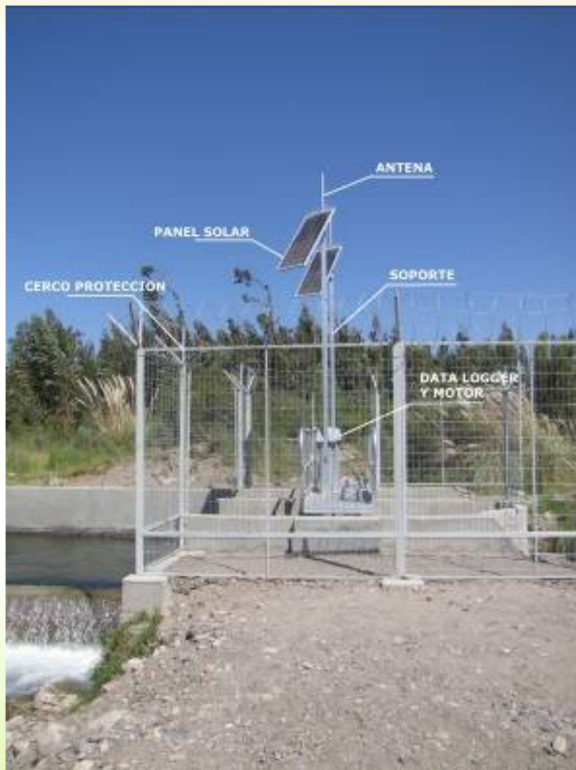
Sección canal con equipos instalados.
