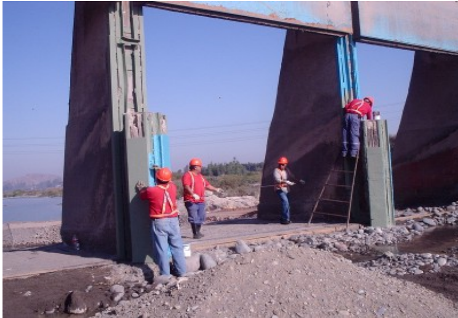
Mantenimiento de estructuras de Bocatoma y Compuertas.
