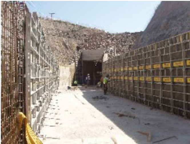
Obras en Canal Espejo. Desvío y revestimiento con hormigón armado.
