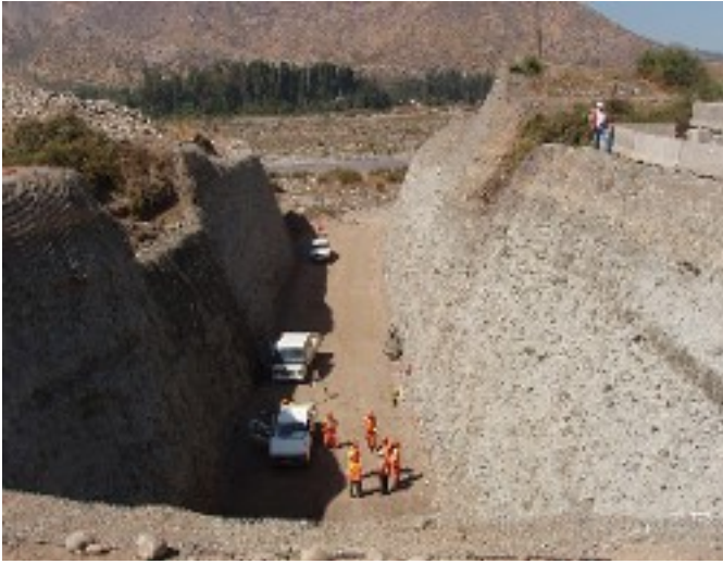
Colector de Puente Alto. Construcción de colector que atraviesa bajo el Canal Tronco y descarga al río Maipo.
