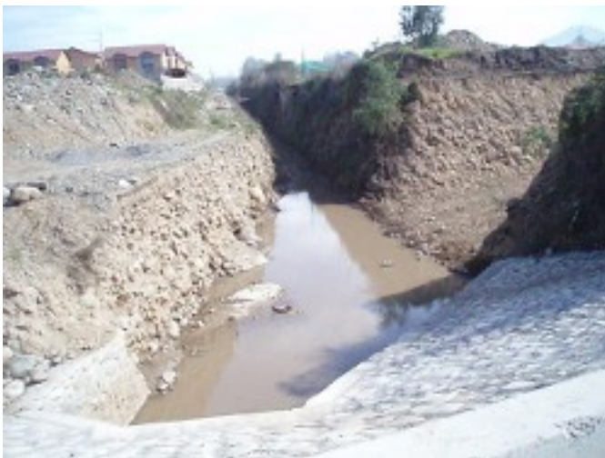
Obras en Canal Ochagavía. Construcción de cruce Autopista y revestimiento de mampostería en piedra en bordes.
