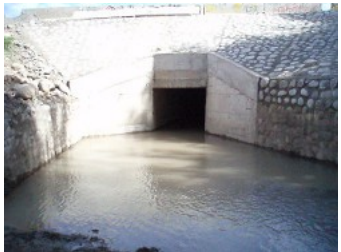
Obras en Canal Ochagavía. Construcción de cruce Autopista y revestimiento de mampostería en piedra en bordes.
