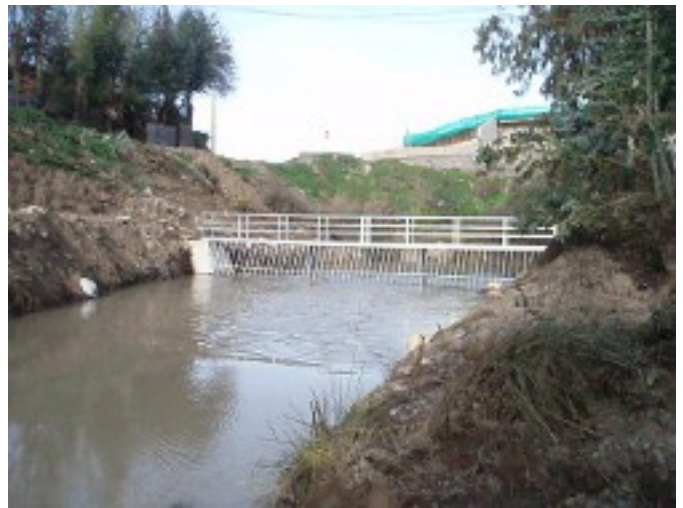
Construcción de reja en canal Unificado. Obra ejecutada con el objetivo de contener basura y escombros.
