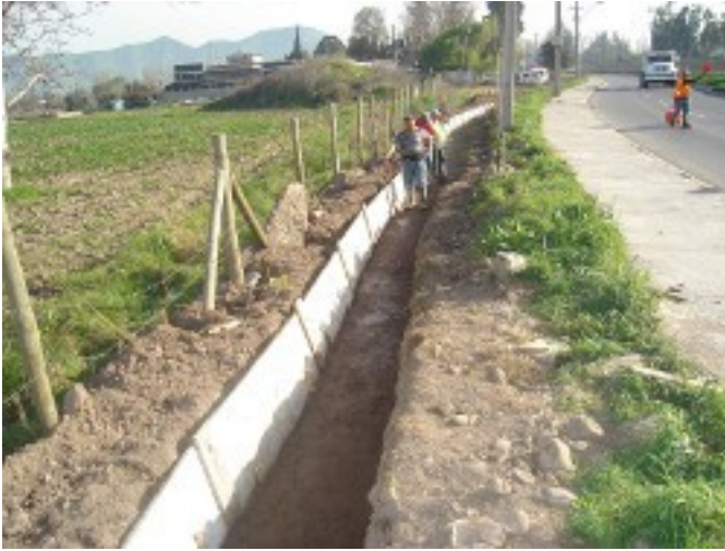
Construcción de acequia de riego en borde de Autopista Central. Obra ejecutada para resolver los problemas de riego del señor Jorge Ezurmendia, con motivo de la construcción de la Autopista Central hace algunos años. Longitud total de 150m.
