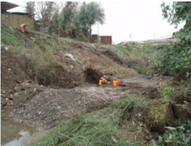
Construcción de reja en canal Unificado. Obra ejecutada con el objetivo de contener basura y escombros.
