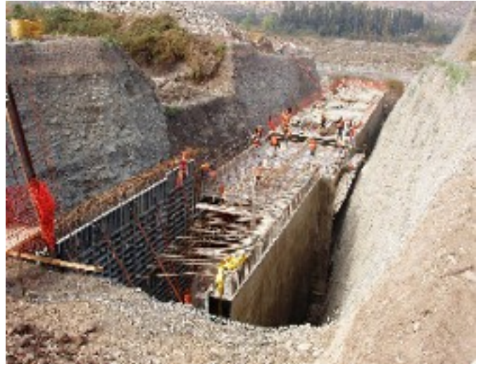
Colector de Puente Alto. Construcción de colector que atraviesa bajo el Canal Tronco y descarga al río Maipo.
