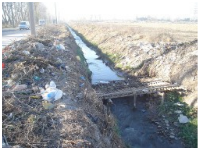
Construcción y ubicación rejas contenedoras de basura en Canal El Bajo, avenida Lo Espejo.
