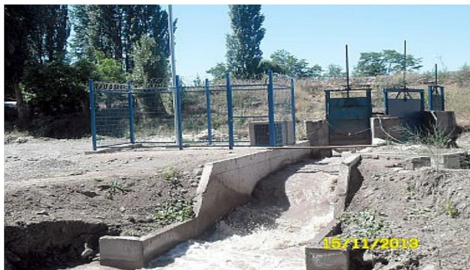
**Figura 4.** Sistema de aforo en Canal Calera
