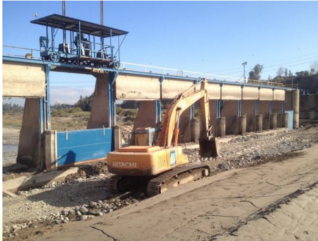
Reemplazo Compuerta Frontal N°1 y N° 9.
