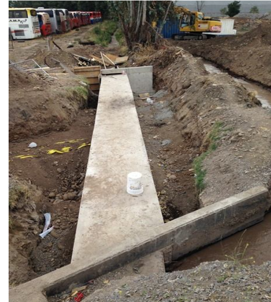
Obra de arte construida
