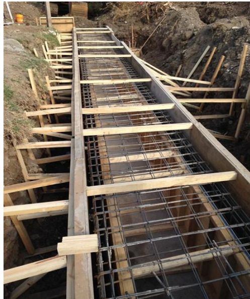
Etapas de construcción
