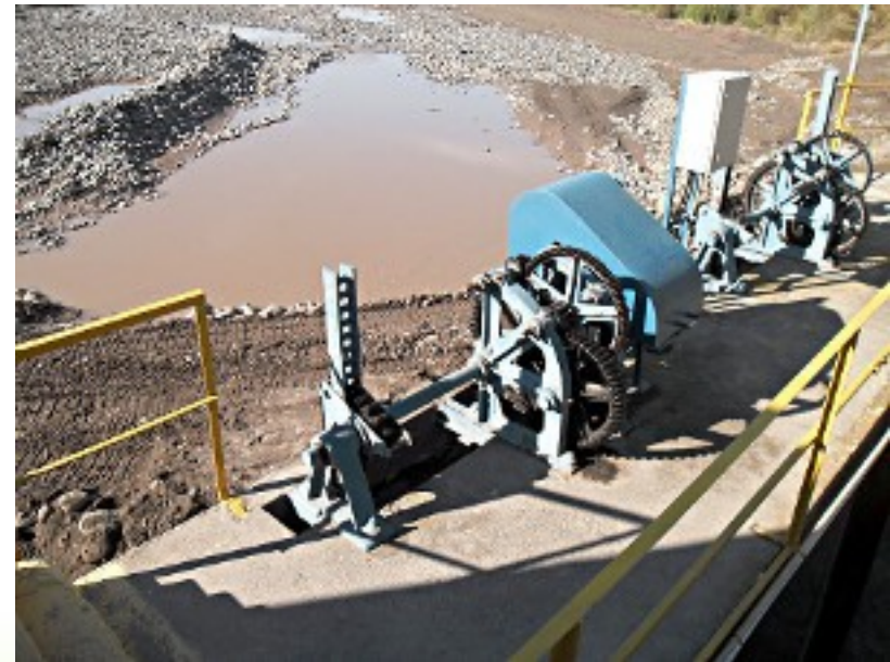
Instalación motor compuerta N°1 Canal Huidobro.
