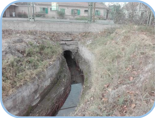
Canal El Descanso, reparación revestimiento muros sector Viña San Antonio, comuna de Calera de Tango.
