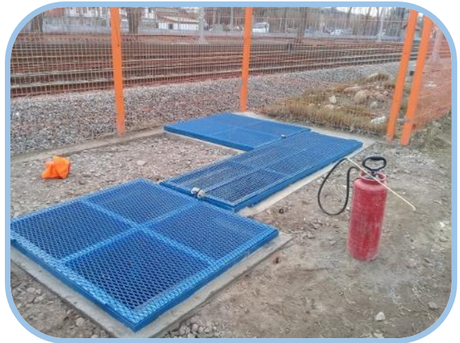
Con proyecto. Muros H.A. y Tapas Metálicas.
