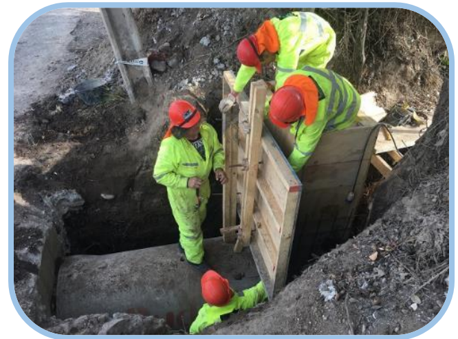
Ejecución. Moldajes de Madera.
