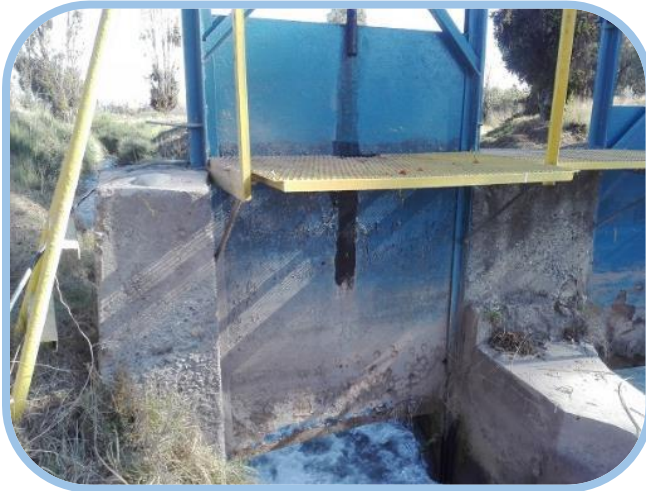
Canal Oliveto, cambio compuerta Lonquén-Oliveto M066, comuna de Calera de Tango.
