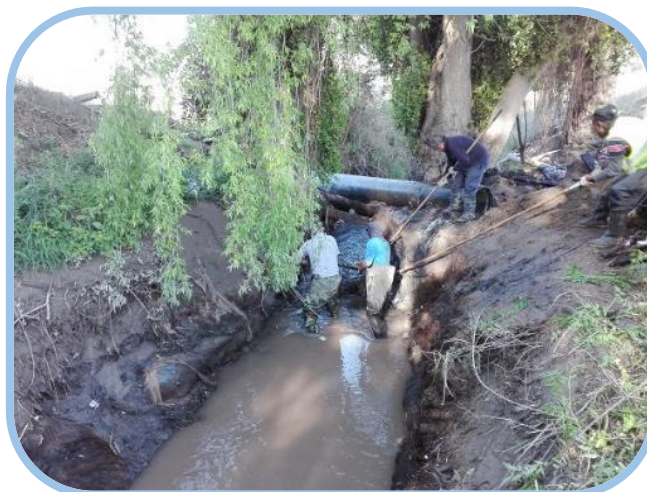
Canal Lonquén - Oliveto, limpieza de emergencia sector Lo Moya, comuna de Calera de Tango.
