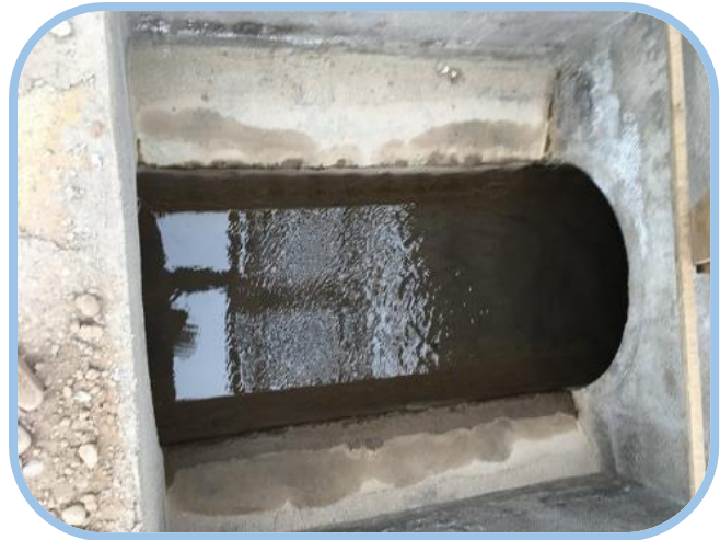
Cámara Inspección sin sedimentador.
