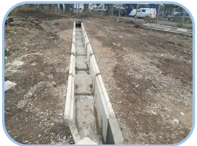
Con Proyecto. Canal San José de Nos. Canaleta Prefabricada H.A. 0,6 m x 0,6
