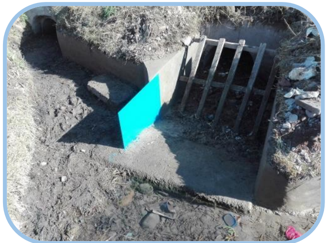
Canal El Bajo, cambio punta partidora marco Aguilera M051, comuna de San Bernardo.
