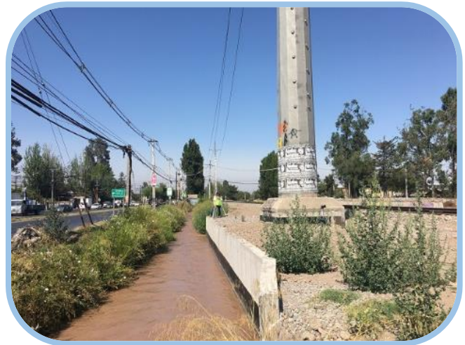
Canal Tagle Gandarilla Sin Proyecto
