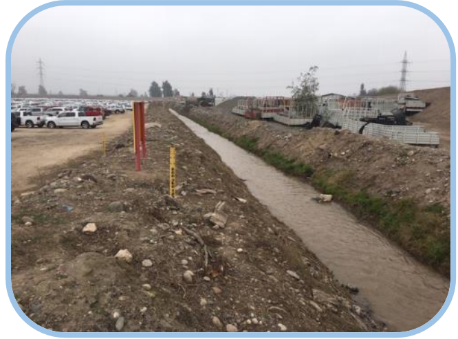
Futura Interferencia con Canal Santa Ana.
