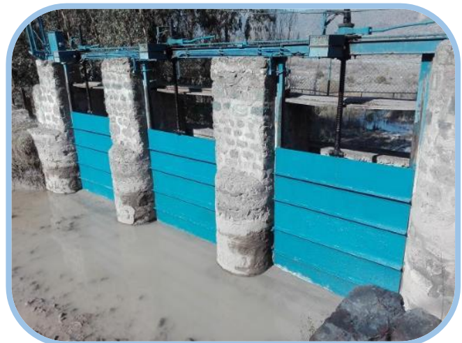
Mantenimiento compuerta N°1 descarga a río Maipo.
