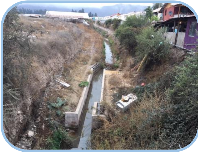
Sin proyecto. Canal en Tierra.
