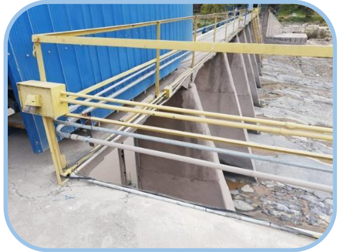
Instalación nueva red eléctrica desde motor generador a Bocatoma.
