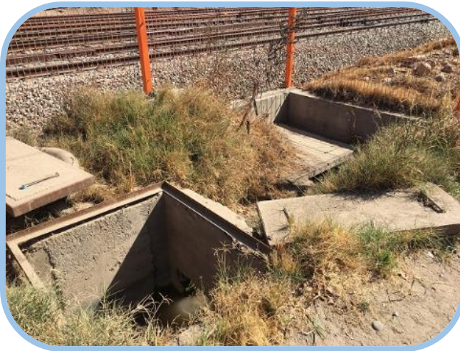
Sin Proyecto. Obras Inconclusas.
