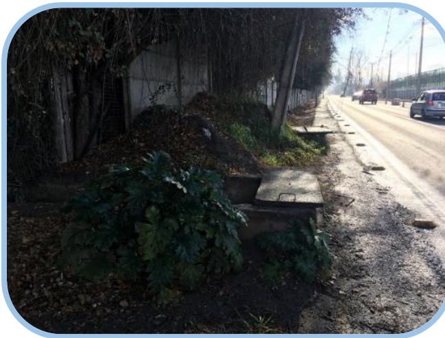
Sin Proyecto. Interferencia Cámaras de Inspección.
