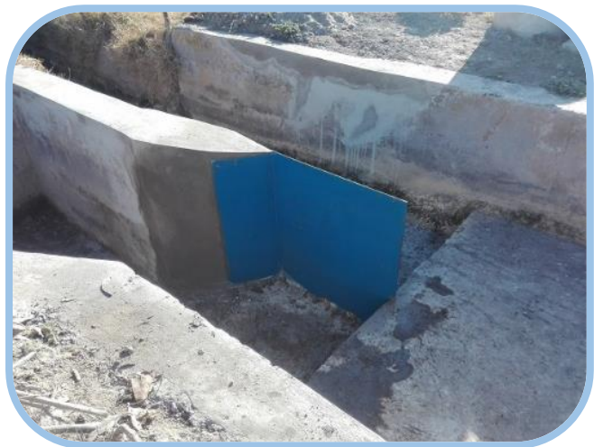
Canal El Descanso, cambio punta partidora Marco El Curato MI I2, comuna de Calera de Tango.
