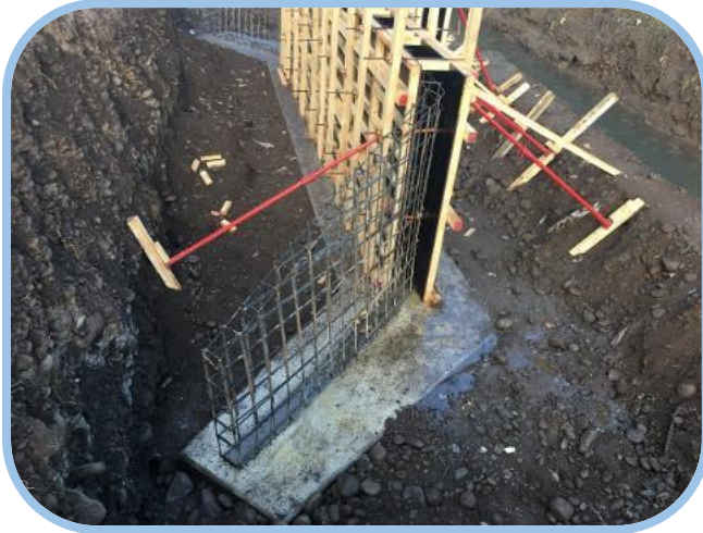
Ejecución. Moldajes de Madera.
