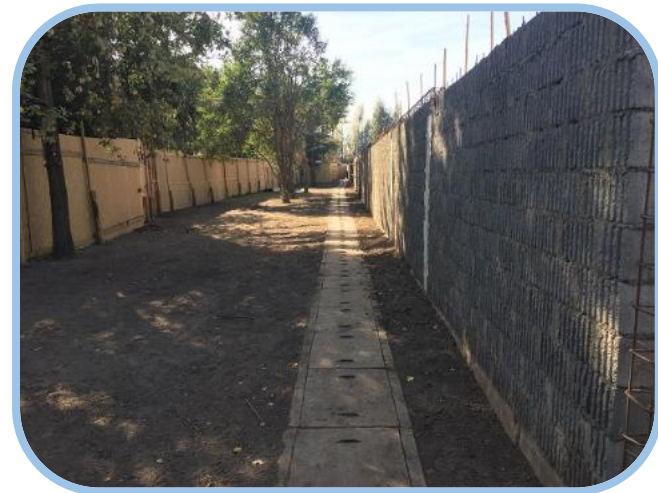
Con Proyecto. Canaleta H.A. Prefabricada.
