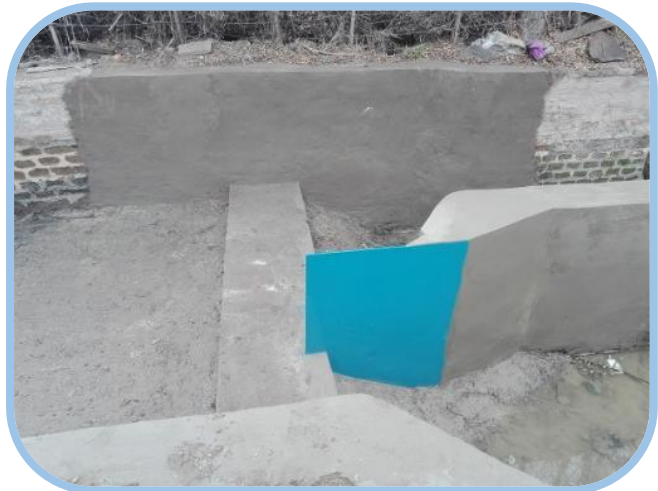
Canal San Vicente, cambio punta partidora Marco El Descanso M083, comuna de Calera de Tango.
