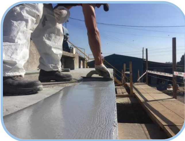
Protección y sellado losa de maniobra compuertas.
