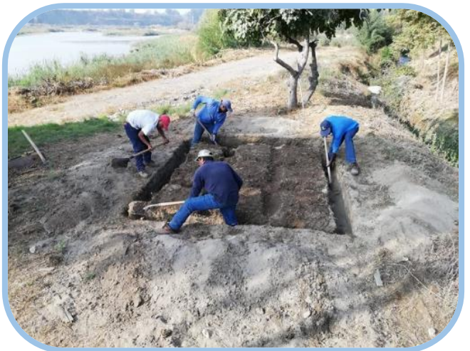
Instalación malla puesta a tierra.
