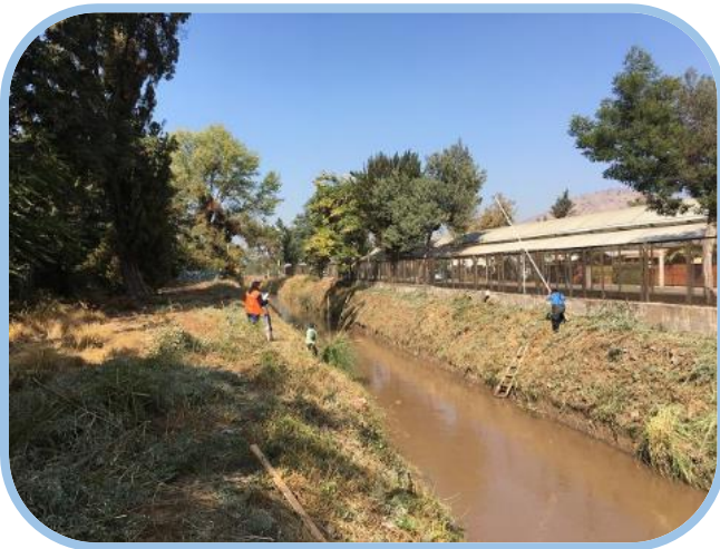
Sin Proyecto. Canal en Tierra.
