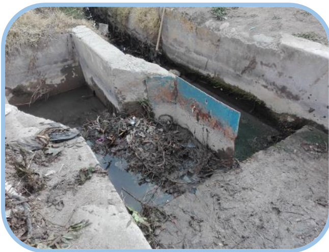
Canal El Descanso, cambio punta partidora Marco El Curato MI I2, comuna de Calera de Tango.
