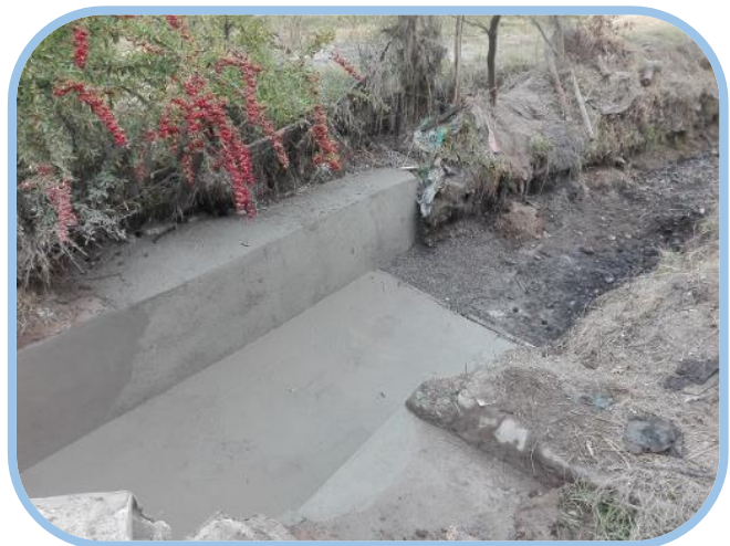
Canal San Vicente Santa Ana, reparación caída Marco San Javier M084, comuna de Calera de Tango.
