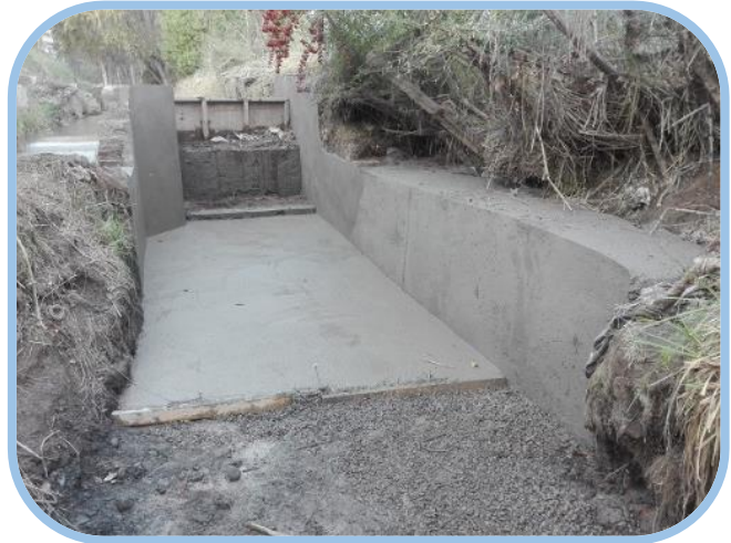
Canal San Vicente Santa Ana, reparación caída Marco San Javier M084, comuna de Calera de Tango.
