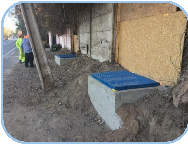
Ejecución. Alargue de Sifones.
