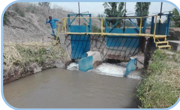
Compuertas Tres Acequias, octubre de 2019.
