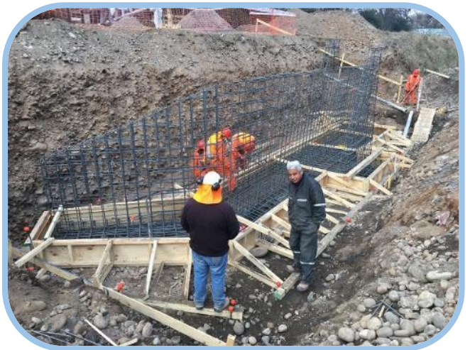
Ejecución. Armadura de Refuerzo.
