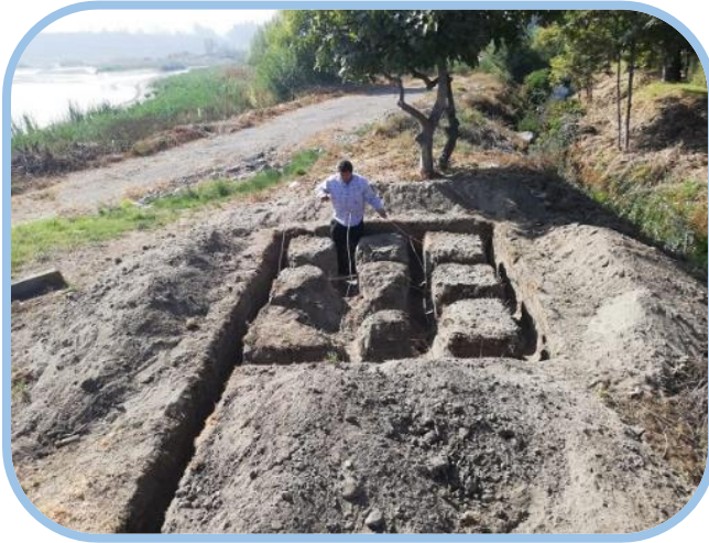
Instalación malla puesta a tierra.
