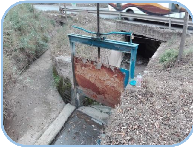
Canal El Descanso, mantención compuerta Bypass Av. Calera de tango, comuna de Calera de Tango.
