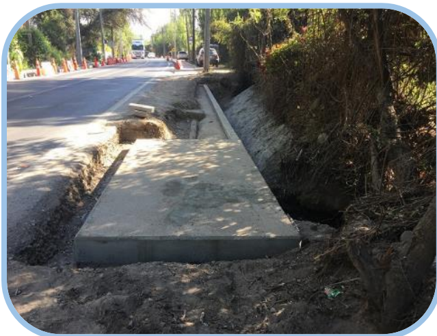
Ejecución. Obras de Protección H.A.
