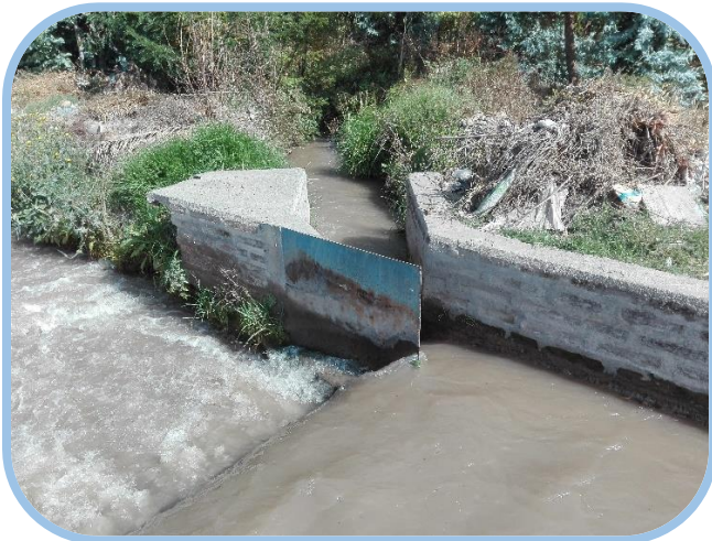
Canal Oliveto, cambio punta partidora Marco Vergara y Otros, comuna de Calera de Tango.
