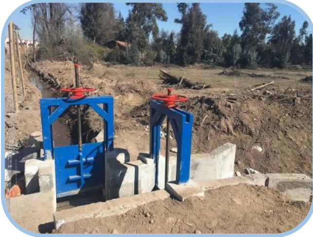
Ejecución. Compuertas de Regulación.
