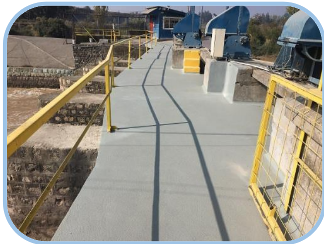
Protección y sellado losa de maniobra compuertas.
