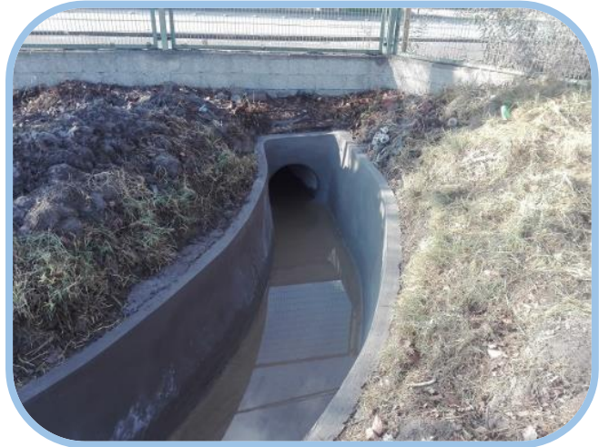
Canal El Descanso, reparación revestimiento muros sector Viña San Antonio, comuna de Calera de Tango.
