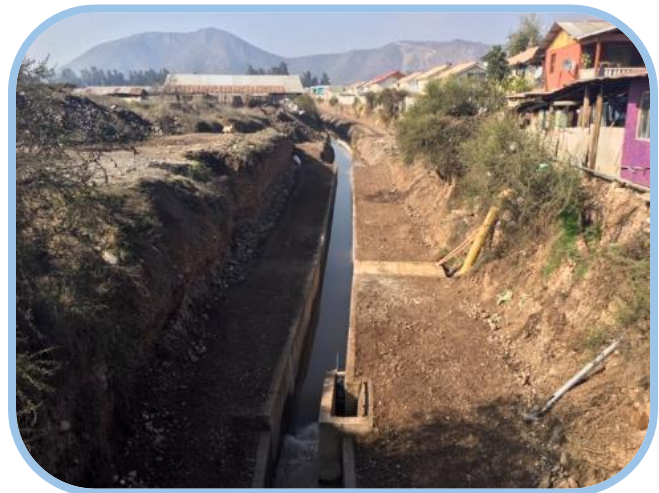
Con proyecto. Canal H.A. 1,3 m x 1.2 m.
