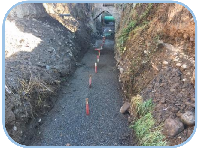
Ejecución. Base Estabilizada.
