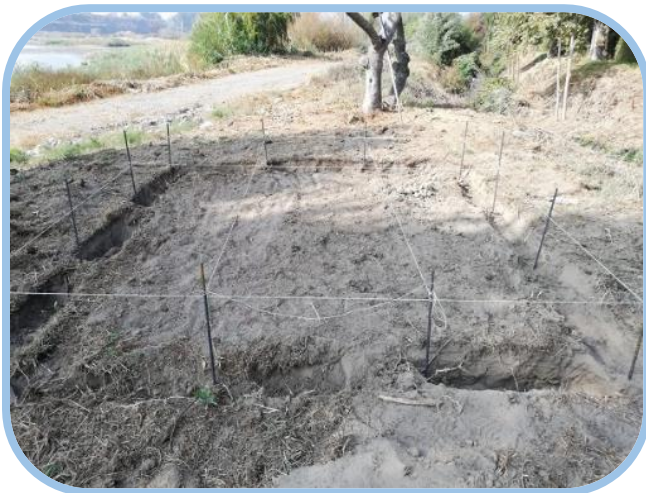
Instalación malla puesta a tierra.
