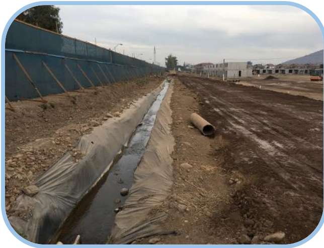
Ejecución. Canal By Pass. Ejecución.
