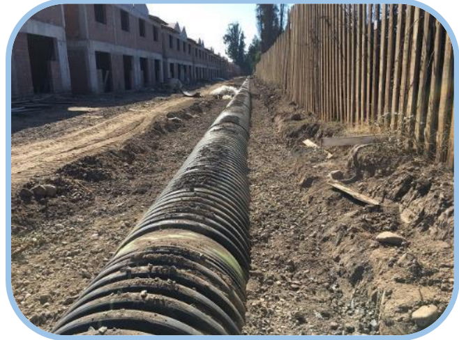
Ejecución. Tubería HDPE D:1.000 mm
