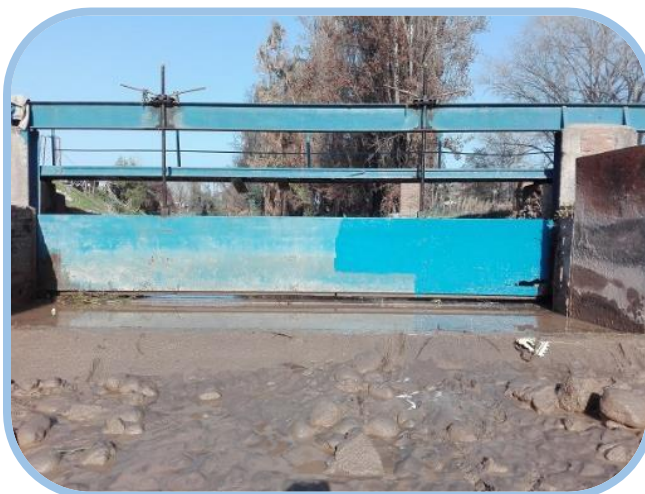
Reparación y mantención compuertas en marco partidor M001.
