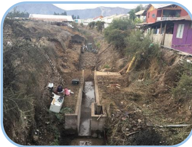
Ejecución. Movimiento de Tierra.
