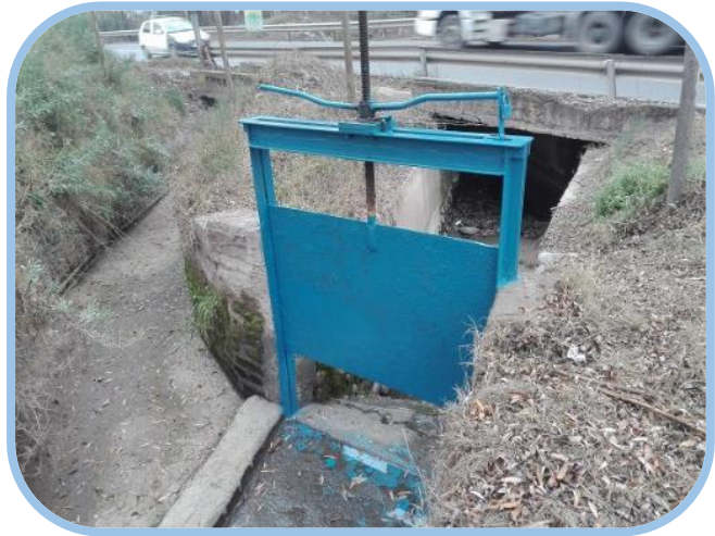
Canal El Descanso, mantención compuerta Bypass Av. Calera de tango, comuna de Calera de Tango.
