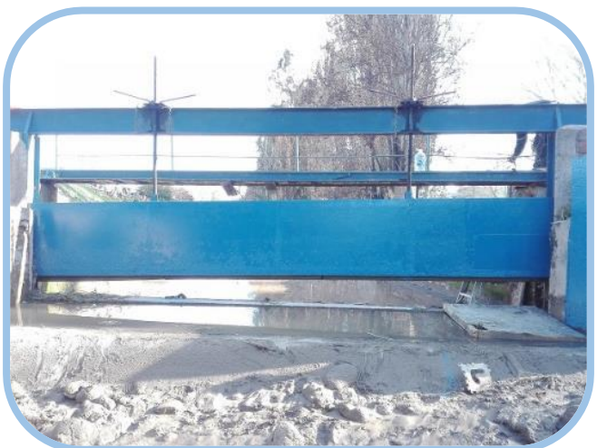
Reparación y mantención compuertas en marco partidor M001.
