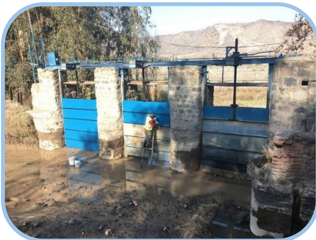
Mantenimiento compuerta N°1 descarga a río Maipo.
