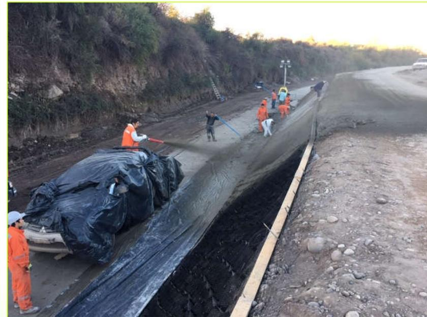
Piso hormigonado y aplicación del shotcrete en el talud. Espesor terminado 12 cm.
