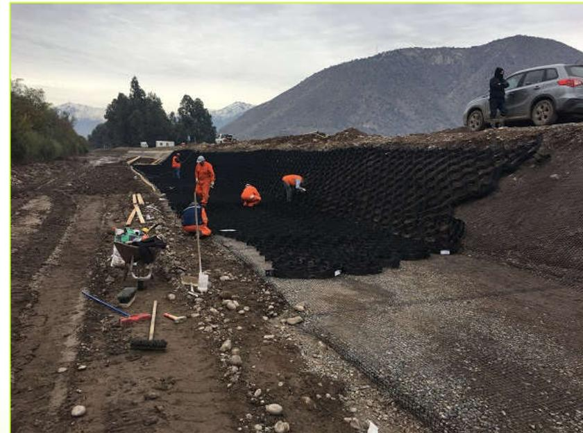
Preparación de la base estabilizada y colocación de la malla Tekcell.
