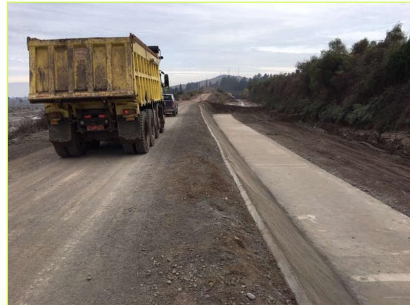
Sección revestida. Ancho de piso 4 m, talud 3 m.
