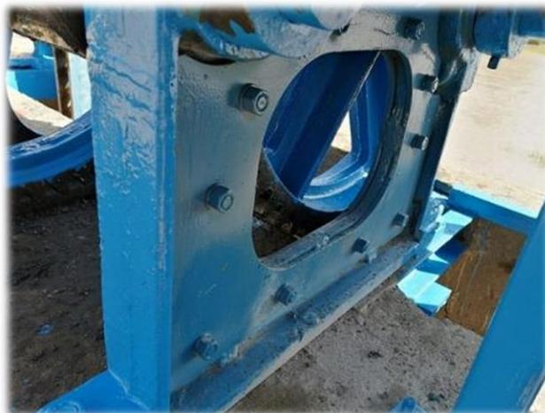
Reparación soporte motor compuerta canal Huidobro.
