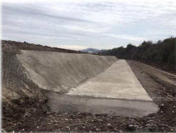
Ancho de piso 4 m, talud 3 m.
