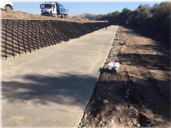
Aplicación del shotcrete en el talud.
