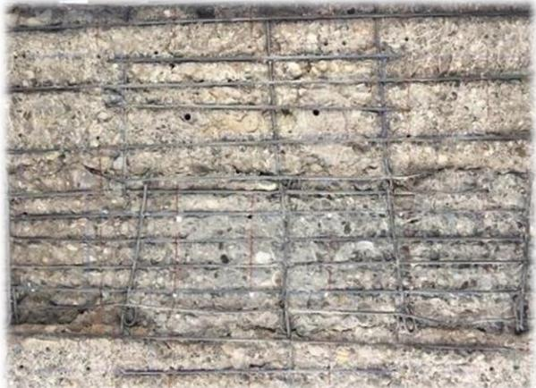
Reparación cara superior de la losa.
