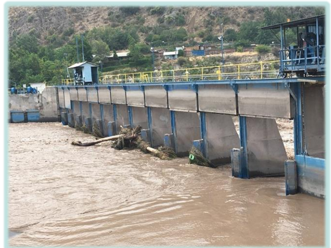
Registro compuertas Bocatoma, luego de la crecida del río Maipo.
