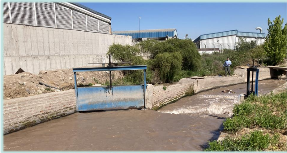
Compuertas marco partidor Santa Ana M012, Canal Espejo, diciembre de 2021.
