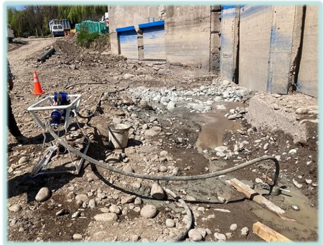
Inyección de lechada cementicia.
