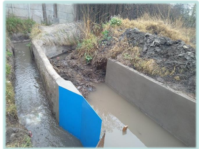
Reparación muro y punta partidora marco M-A, interior canal El Manzano, comuna de Calera de Tango.
