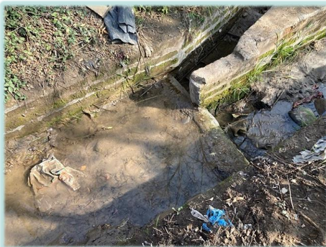
Reparación marco y punta partidora M011-A1, interior canal Bacteriológico, comuna de San Bernardo.
