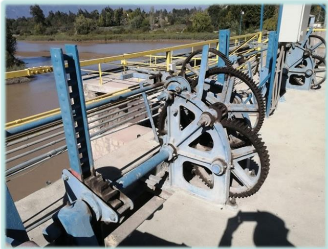
Mantenimiento engranajes compuertas altas.
