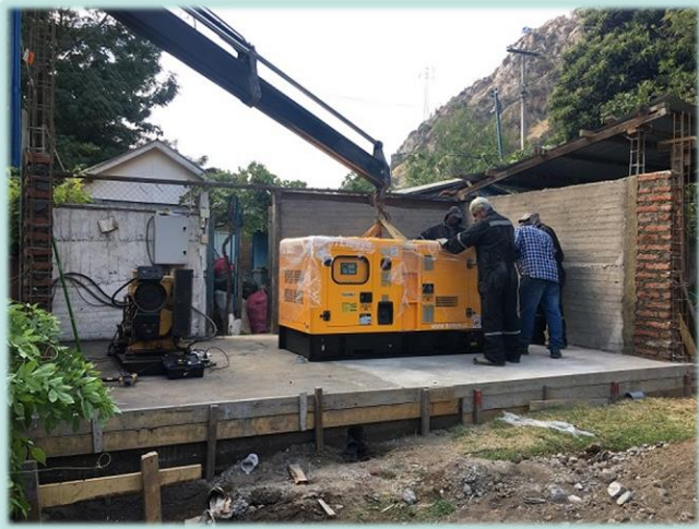
Reparación bodega e instalación nuevo generador.
