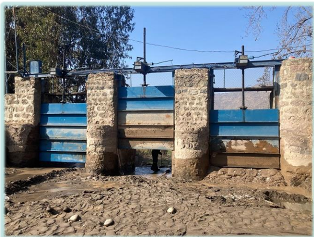
Mantenimiento compuertas N°1 descarga a río Maipo.
