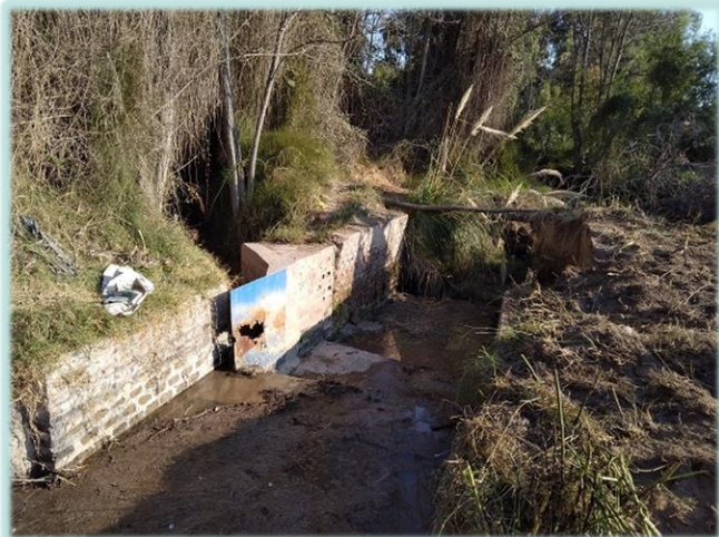
Canal Lonquén – Oliveto, reparación punta partidora marco M093, comuna de Calera de Tango.
