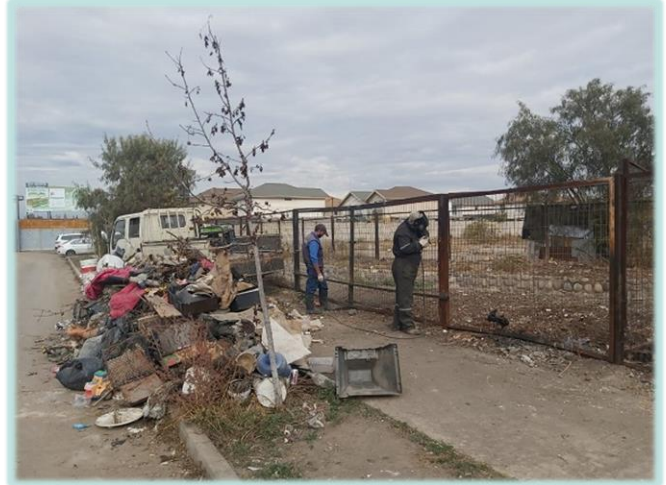
Canal Santa Cruz, retiro de basuras y reparación portón de acceso, comuna de Padre Hurtado.
