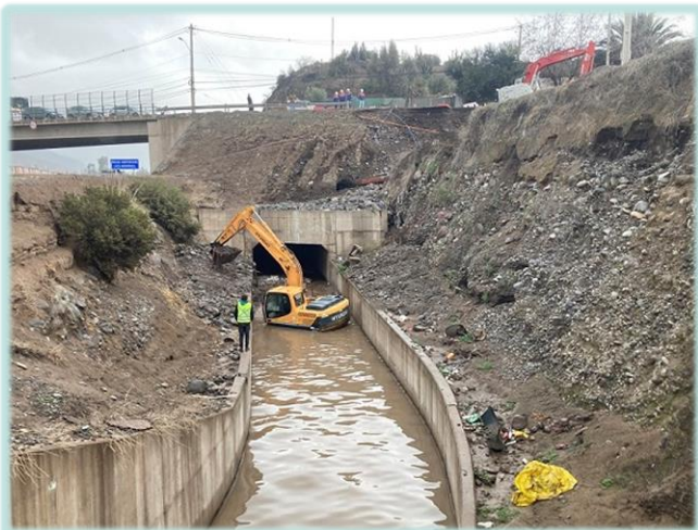
Limpieza con máquina excavadora, se retira todo el material del interior del Canal Espejo.
