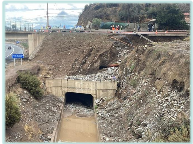
Deslizamiento de material al interior del Canal Espejo, sector Puesto Los Morros, costado Autopista Acceso Sur.
