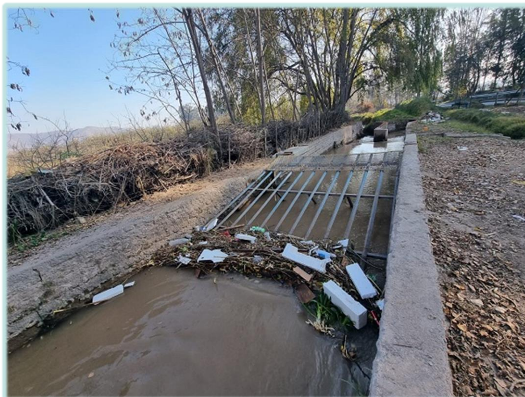
Reja contenedora de basuras Tres Puentes, Septiembre 2021.
