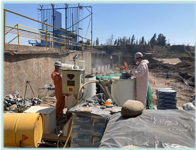
Inyección de lechada cementicia.
