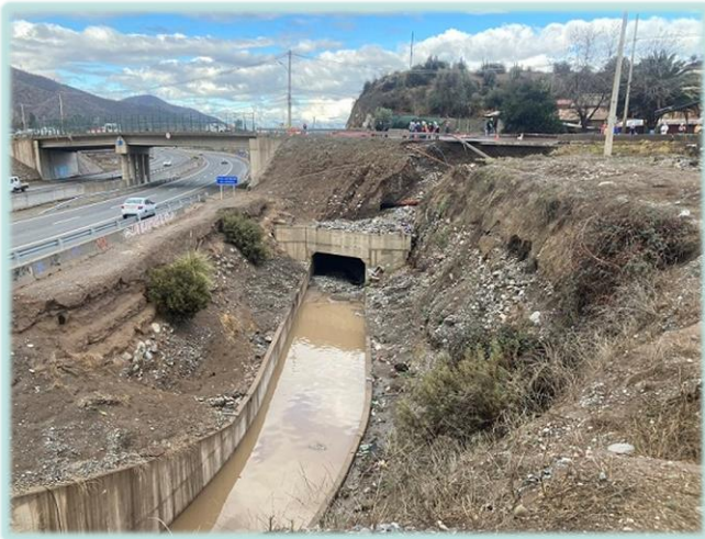
Deslizamiento de material al interior del Canal Espejo, sector Puesto Los Morros, costado Autopista Acceso Sur.
