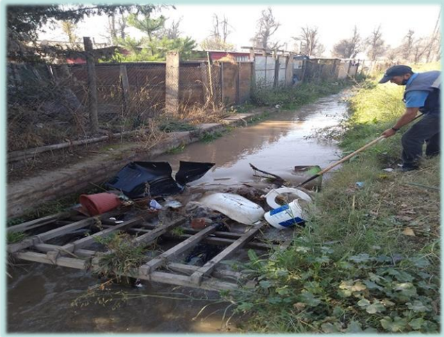
Canal Santa Ana, limpieza reja contenedora de basura, comuna de San Bernardo.
