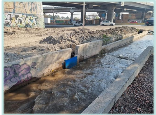
Reparación barrera y punta partidora marco M017-A, interior canal El Pueblo de Maipú, comuna de Maipú.
