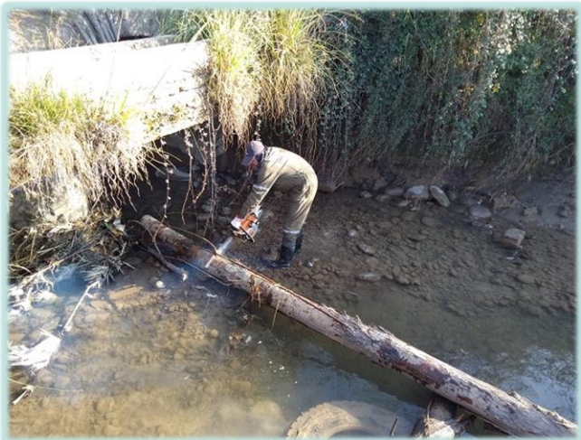
Canal Espejo, corte y retiro de árbol sector San León, comuna de San Bernardo.
