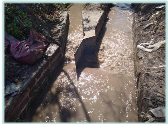
Reparación marco y punta partidora M011-A1, interior canal Bacteriológico, comuna de San Bernardo.
