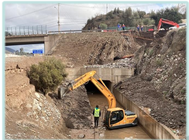
Limpieza con máquina excavadora, se retira todo el material del interior del Canal Espejo.
