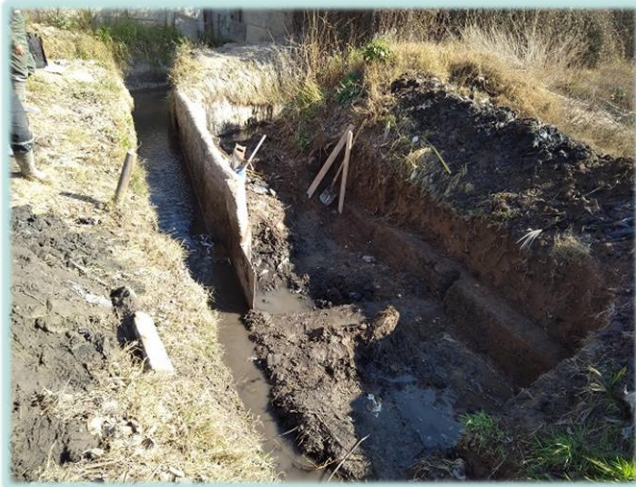
Reparación muro y punta partidora marco M-A, interior canal El Manzano, comuna de Calera de Tango.
