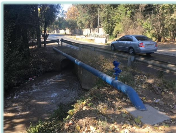
Atraveso aéreo canal Santa Cruz.
