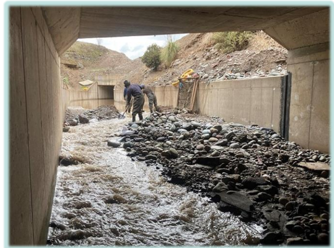
Limpieza manual al interior para evacuar las aguas acumuladas y facilitar el ingreso de maquinaria.
