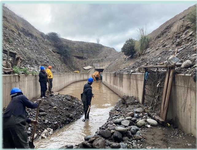
Limpieza manual al interior para evacuar las aguas acumuladas y facilitar el ingreso de maquinaria.
