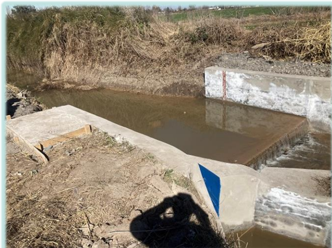
Canal San Vicente, reparación marco, para instalación equipo de Telemetría, comuna de Celera de Tango.
