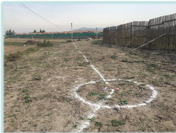
Ejecución. Revisión de trazado.
