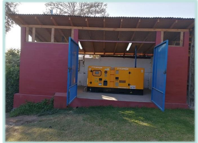
Reparación bodega e instalación nuevo generador.
