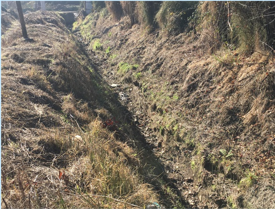
Revestimiento Canal Descarga Santa Cruz, L=68m, sección 1,0x0,85m, año 2019.
