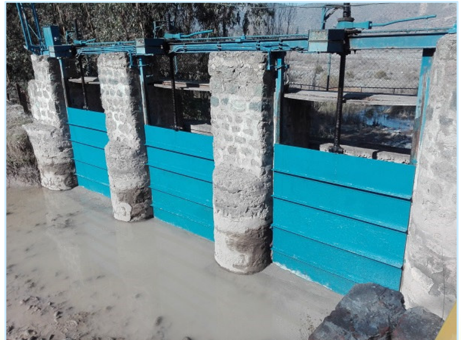
Mantenimiento compuerta N°1 descarga a río Maipo.
