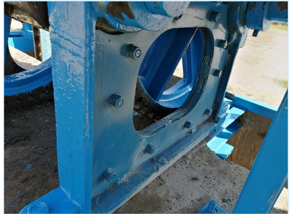
Reparación soporte engranajes compuerta Canal Huidobro.
