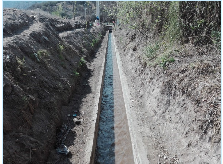
Revestimiento Canal Descarga Santa Cruz, L=68m, sección 1,0x0,85m, año 2019.
