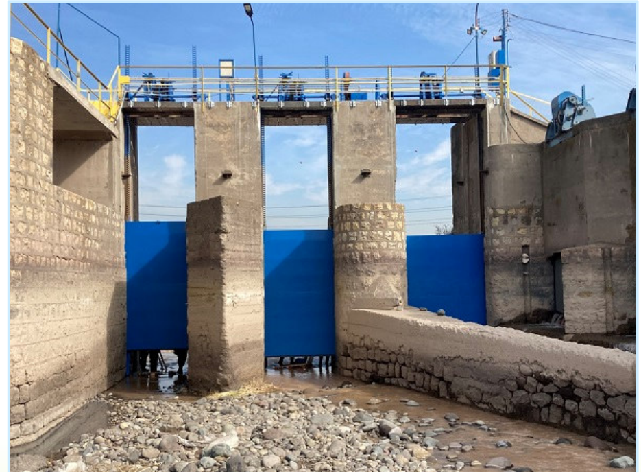
Mantenimiento compuertas Bocatoma.
