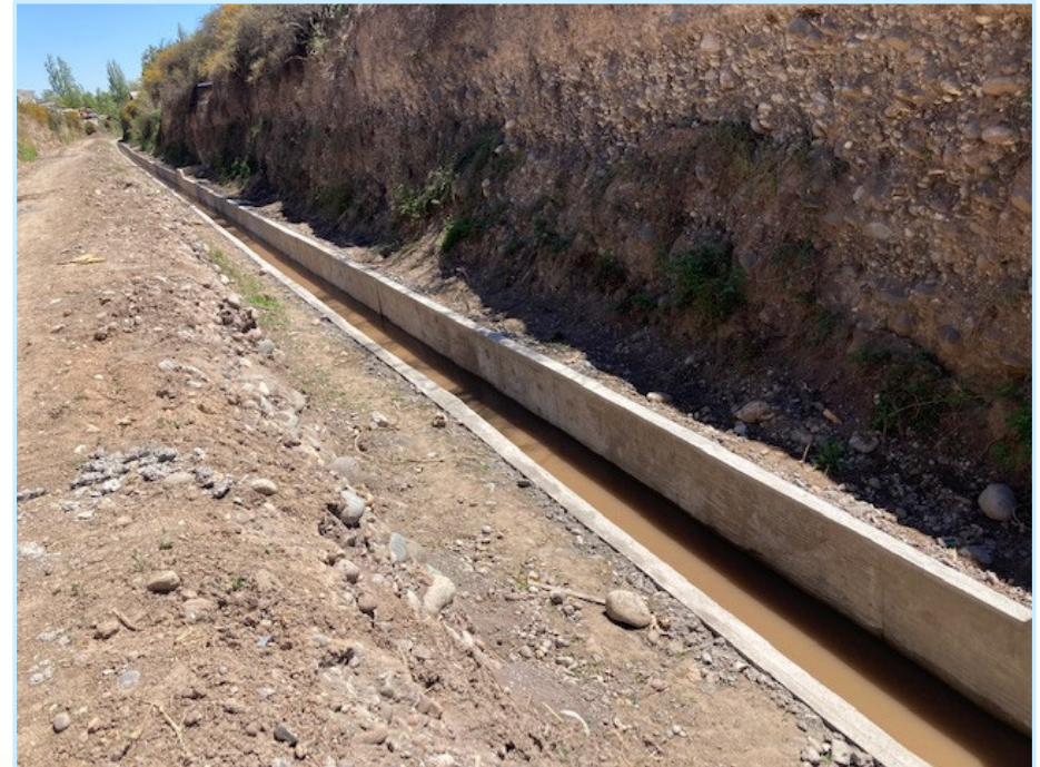
Revestimiento Canal Ochagavía, L= 564m, sección 1,3x1,0m, año 2021.
