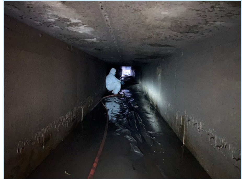
Terminada la limpieza
