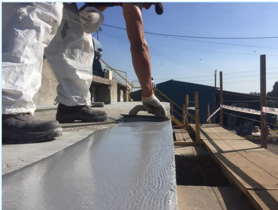
Protección y sellado losa de maniobra compuertas.
