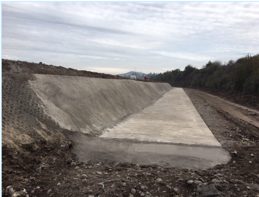
Revestimiento 260 metros borde sur Canal Tronco.
