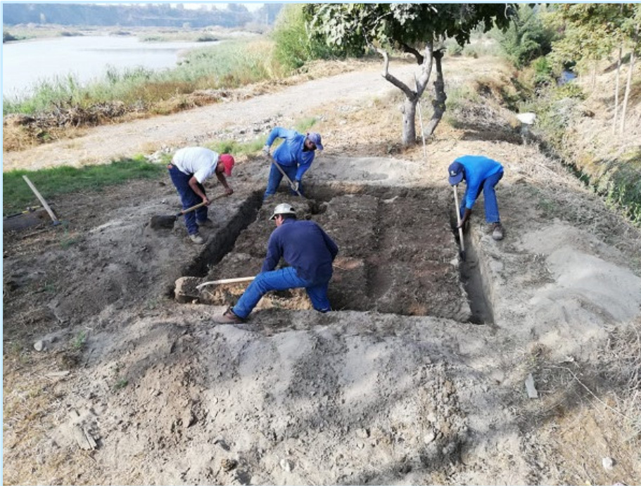
Instalación malla puesta a tierra.
