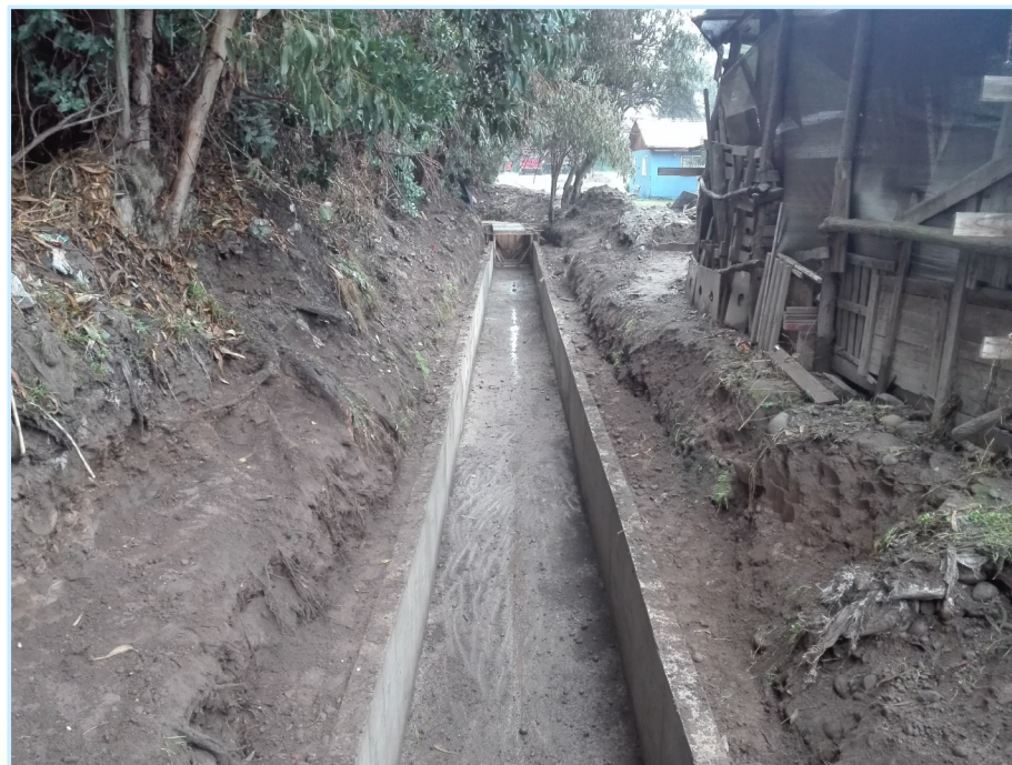
Revestimiento Canal El Descanso, L= 58m, sección 1,5x1,0m, año 2019.
