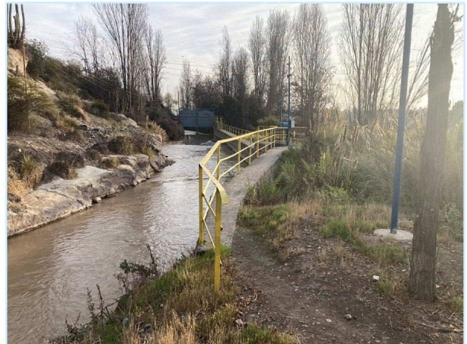
Instalación baranda en pasarela costado Canal Huidobro.
