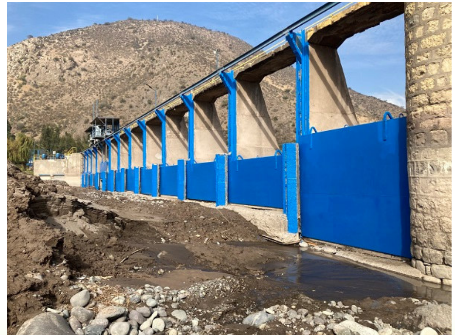
Mantenimiento compuertas Bocatoma.
