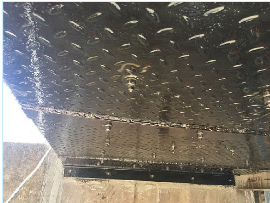
Reparación losa maniobra compuertas altas.
