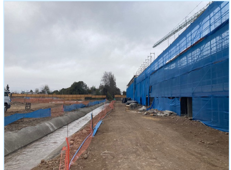
Proyecto ejecutado. Puesta en Servicio
