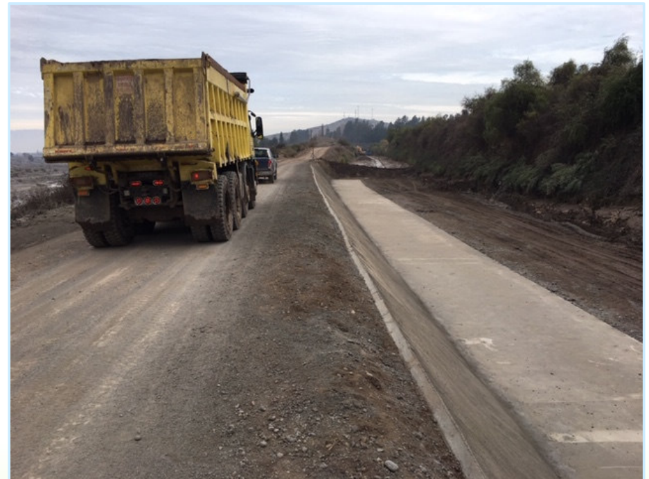
Revestimiento 260 metros borde sur Canal Tronco.
