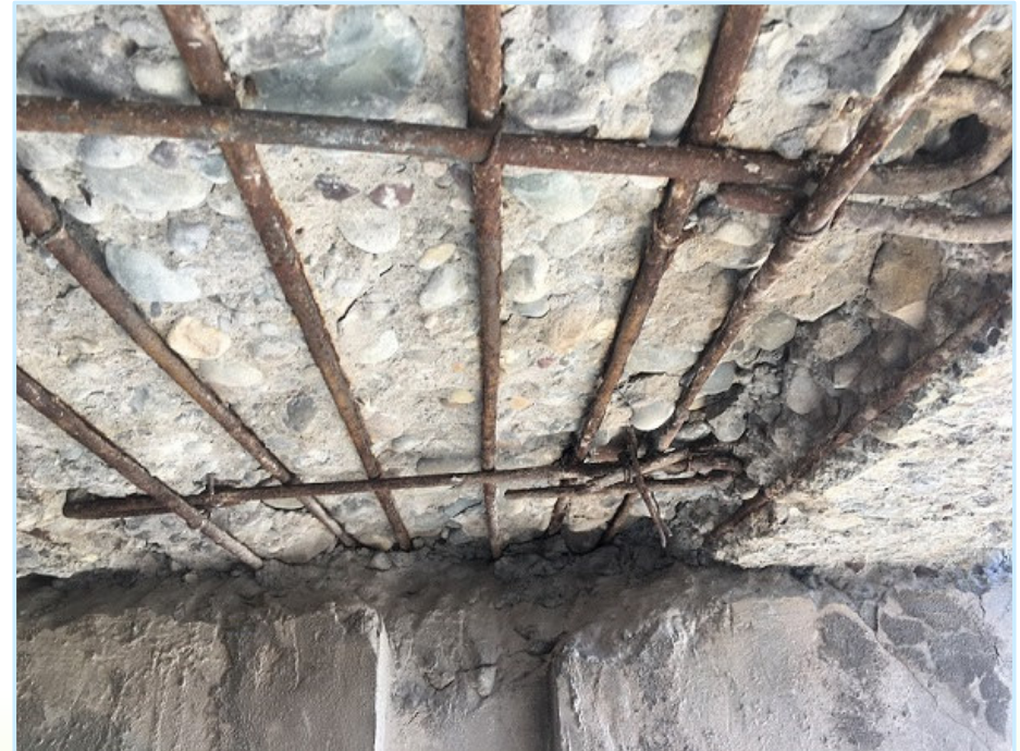
Reparación losa maniobra compuertas altas.
