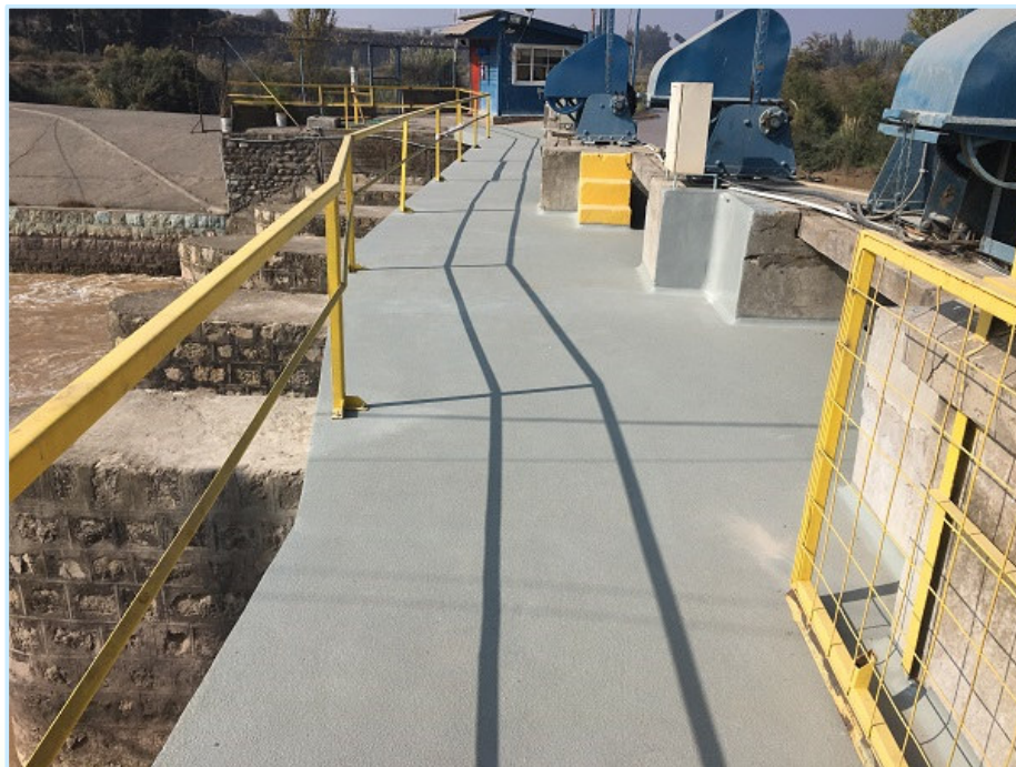
Protección y sellado losa de maniobra compuertas.
