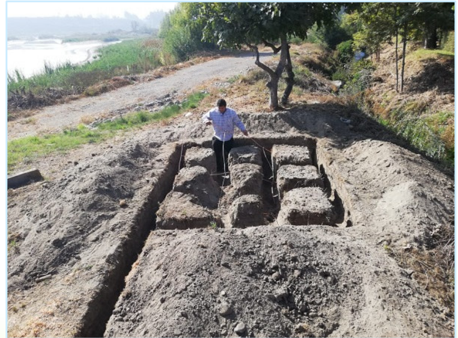
Instalación malla puesta a tierra.
