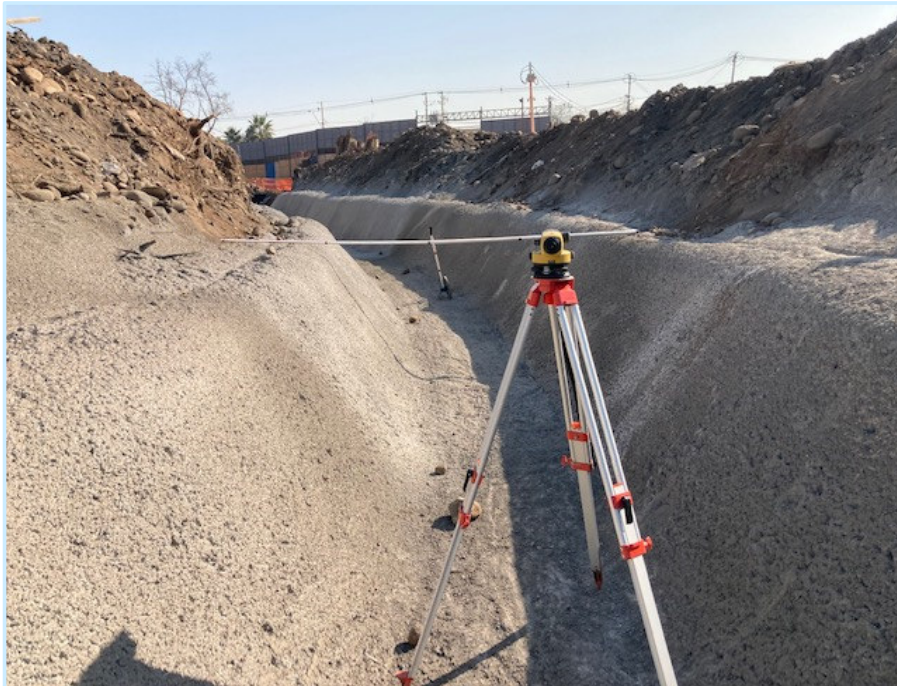
Chequeo Topográfico de Revestimiento Ejecutado
