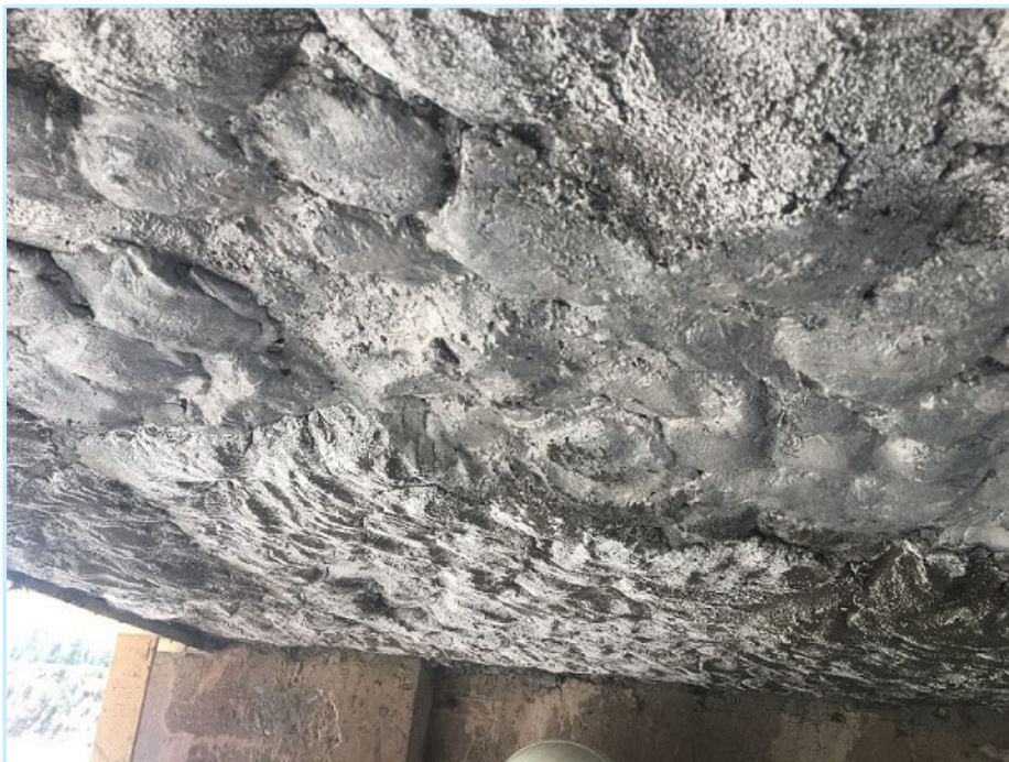
Reparación losa maniobra compuertas altas.
