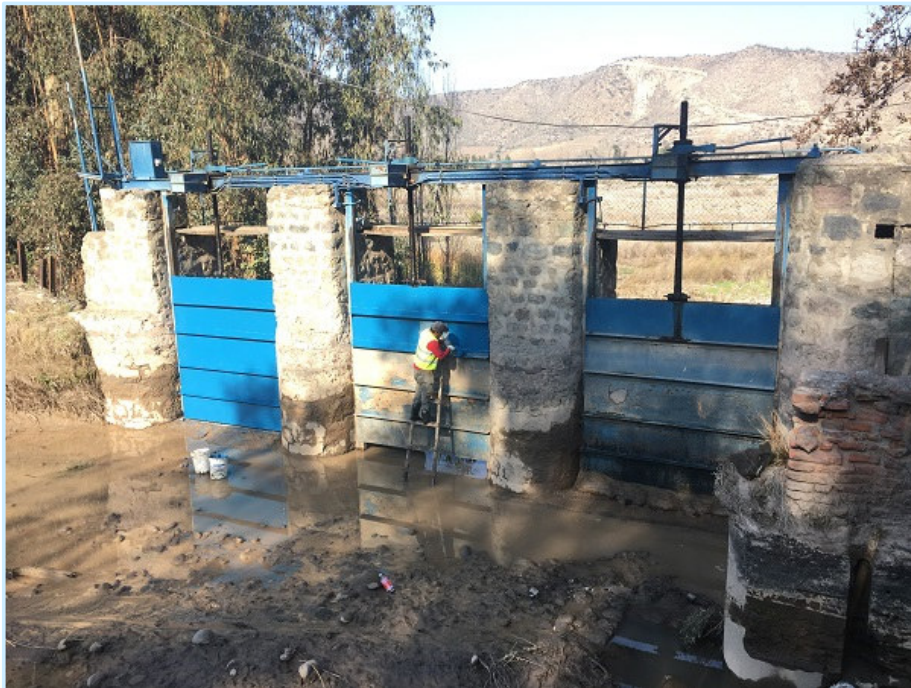
Mantenimiento compuerta N°1 descarga a río Maipo.
