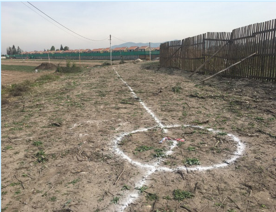
Ejecución. Revisión de trazado
