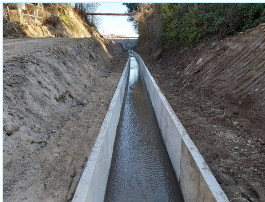
Revestimiento Canal Ochagavía, L= 138m, sección 1,3x1,0m, año 2020.
