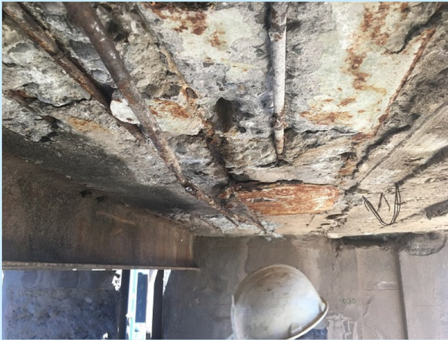
Reparación losa maniobra compuertas altas.
