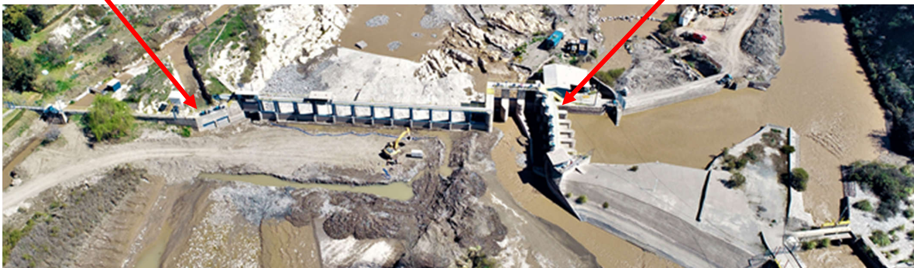
Bocatoma El Clarillo
