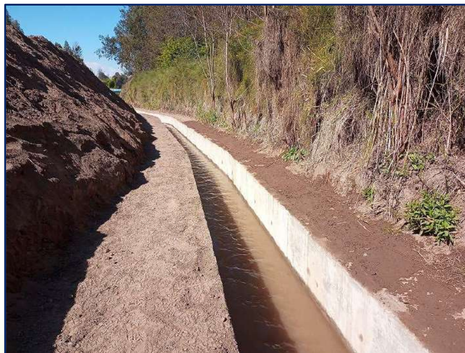
Obra en operación
