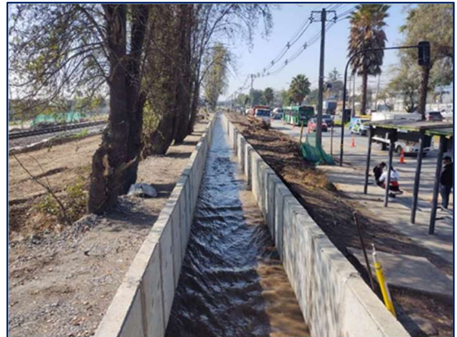
Tramo ejecutado canal Tagle-Gandarillas
