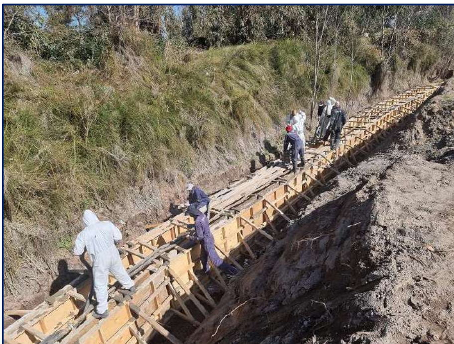
Proceso de construcción
