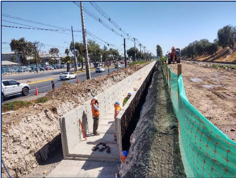
Ejecución canal Tagle-Gandarillas
