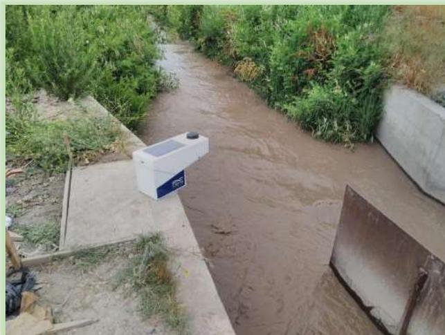
Construcción base hormigón en canal espejo para equipo telemetría marco partidor M017, comuna Maipú.
