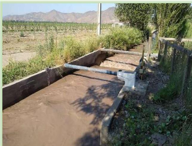
Base hormigón en canal Lonquén - Oliveto para equipo telemetría marco partidor M150, comuna Calera de Tango.
