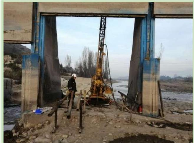
Registro fotográfico testigos de sondajes en fundación Bocatoma.
