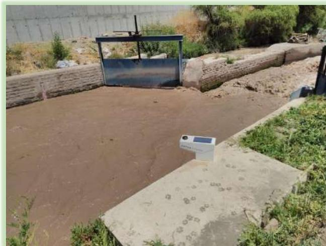
Construcción base hormigón en canal espejo para equipo telemetría marco partidor M012, comuna San Bernardo.
