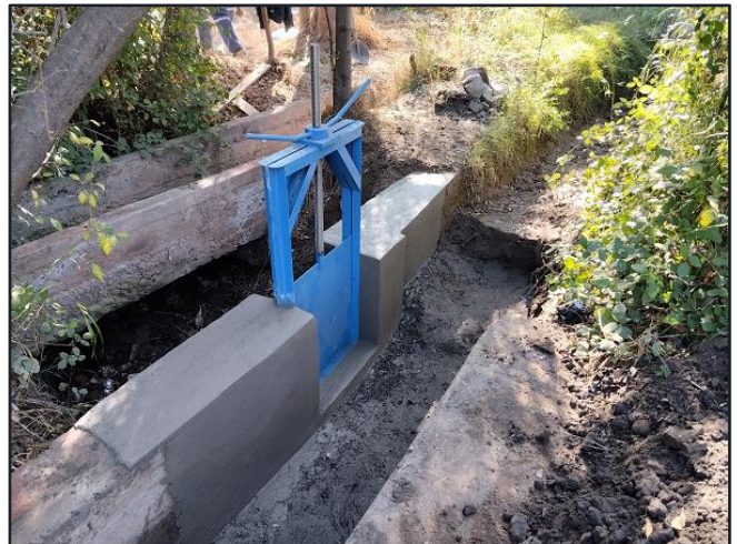
Reparación compuerta de distribución comunidad Santa Sofia, comuna Calera de Tango.
