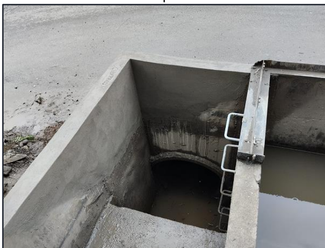
Reparación muros salida sifón canal Seminario sector Autopista del Sol, comuna Maipú.
