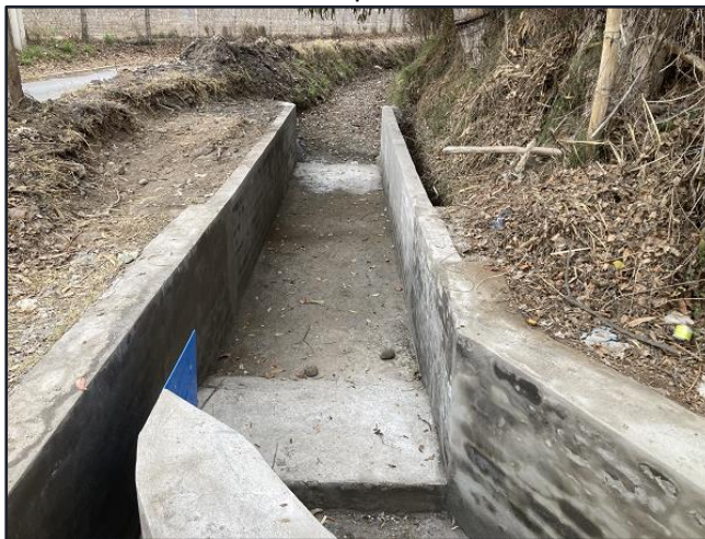
Reparación marco partidor M074 en canal Santa Cruz, comuna Calera de Tango.
