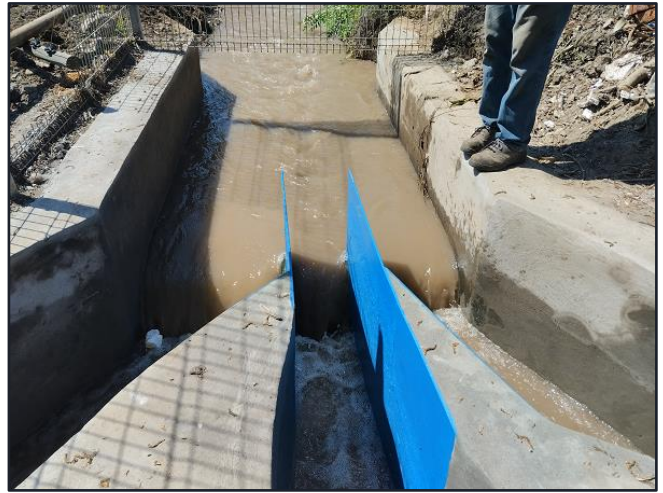
Reparación marco partidor El Trébol-La Ermita-La Rinconada M012-3B, comuna Calera de Tango.
