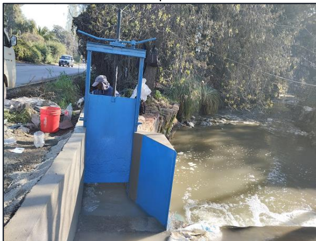
Reparación marco partidor M011 y compuerta en Canal Espejo, comuna San Bernardo.
