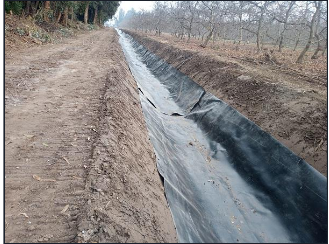
Canal Capilla Santa Cruz, mejoramiento 750 m de canal con geomembrana, comuna San Bernardo.
