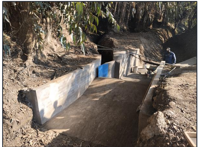
Canal Santa Cruz, reparación marco partidor M069, comuna Calera de Tango.
