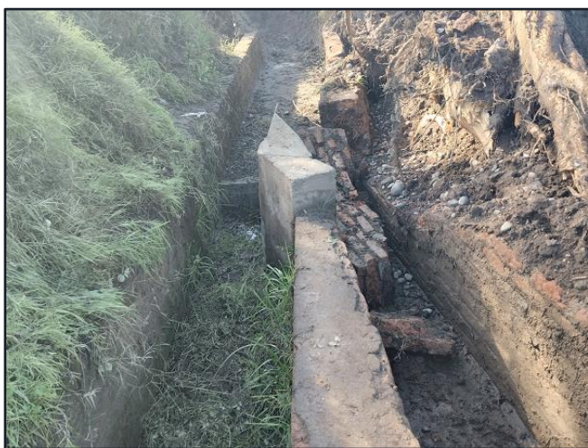
Reparación marco partidor interior Lo Moya-Nueva Independencia M078-2, comuna Calera de Tango.
