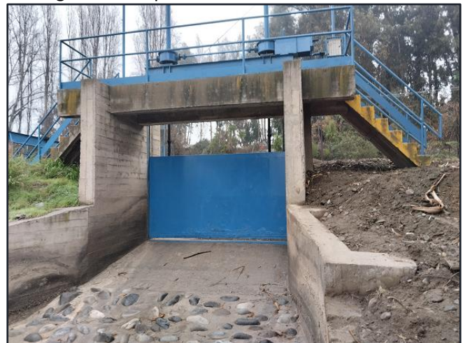
Mantenición compuertas descarga a río Maipo.
