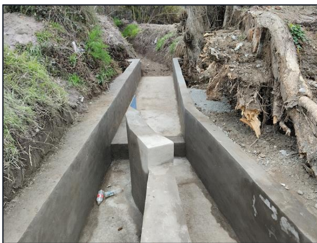
Reparación marco partidor interior Lo Moya-Nueva Independencia M078-2, comuna Calera de Tango.
