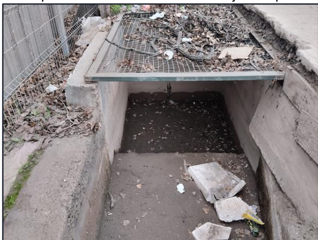
Limpieza sifón canal Flora Infante bajo Autopista Central, mediante camión Hidrojet, comuna San Bernardo.
