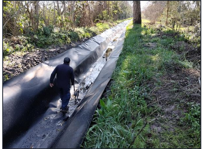
Canal Echazarreta, mejoramiento 300 m de canal con geomembrana, comuna Calera de Tango.
