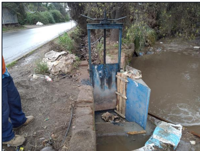
Reparación marco partidor M011 y compuerta en Canal Espejo, comuna San Bernardo.
