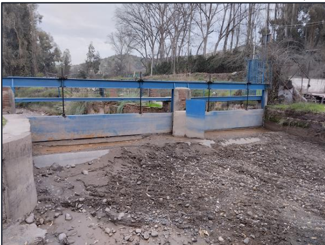
Mantenición compuertas marco partidor M001.
