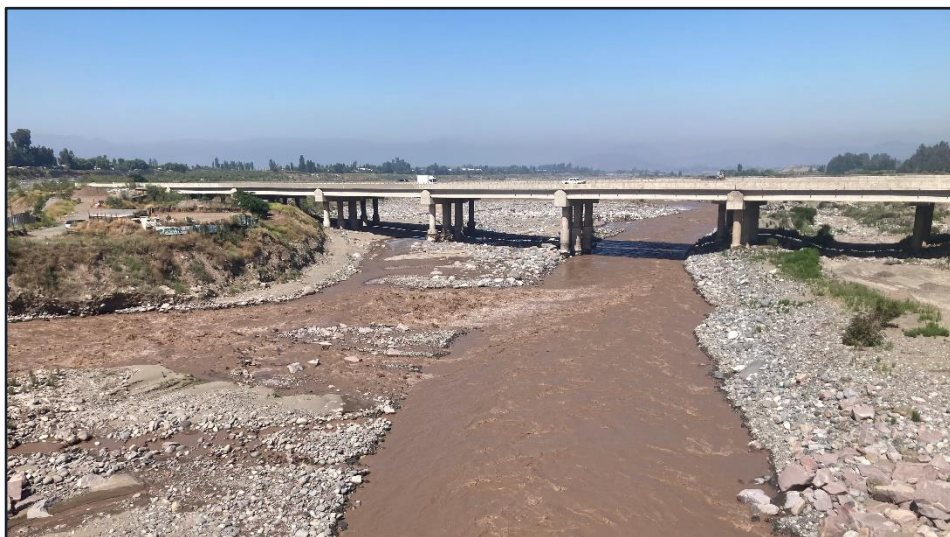
Río Maipo, en puente Autopista Acceso Sur, noviembre de 2023.
