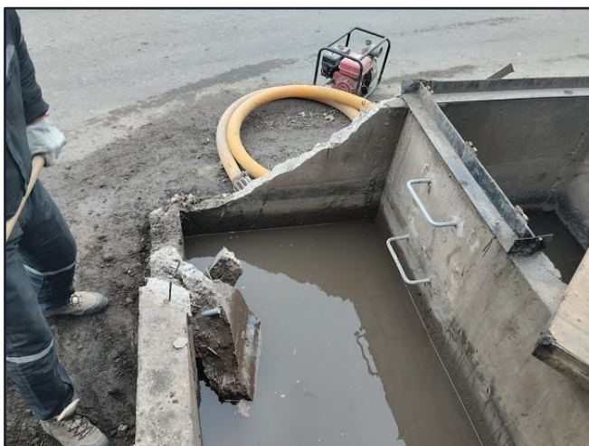
Reparación muros salida sifón canal Seminario sector Autopista del Sol, comuna Maipú.
