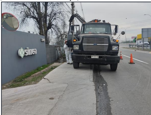
Limpieza sifón canal Flora Infante bajo Autopista Central, mediante camión Hidrojet, comuna San Bernardo.
