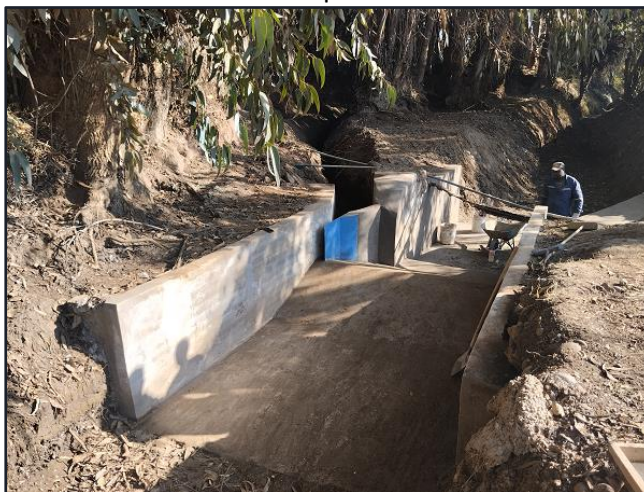
Reparación marco partidor M069 en canal Santa Cruz, comuna Calera de Tango.
