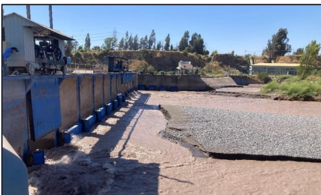
Bocatoma El Clarillo, enero de 2024.
