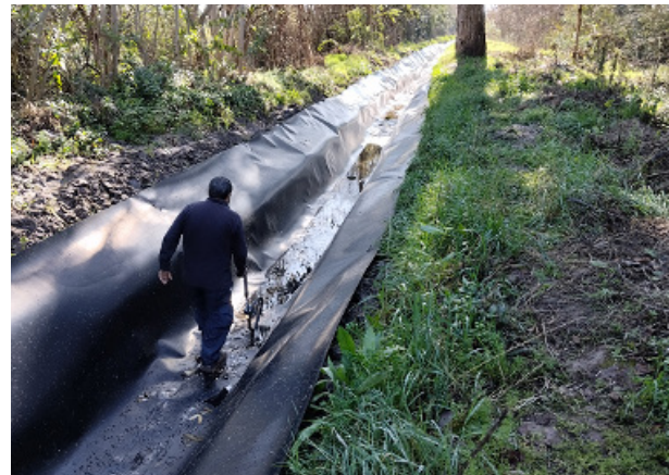
Canal Echazarreta, mejoramiento 300 m de canal con geomembrana, comuna Calera de Tango.
