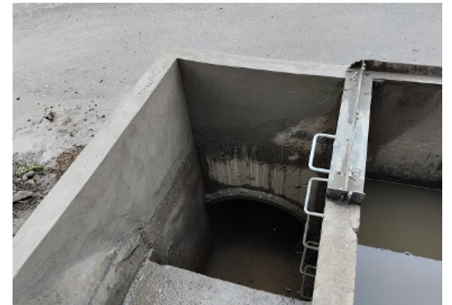
Reparación muros salida sifón canal Seminario sector Autopista del Sol, comuna Maipú.
