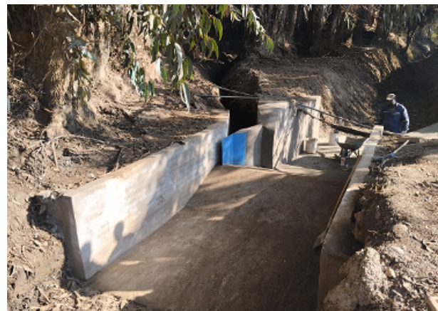
Canal Santa Cruz, reparación marco partidor M069, comuna Calera de Tango.
