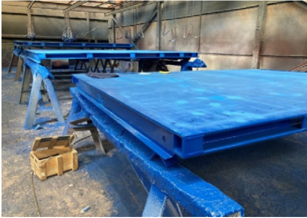
Reparación Compuertas Norte Bocatoma
