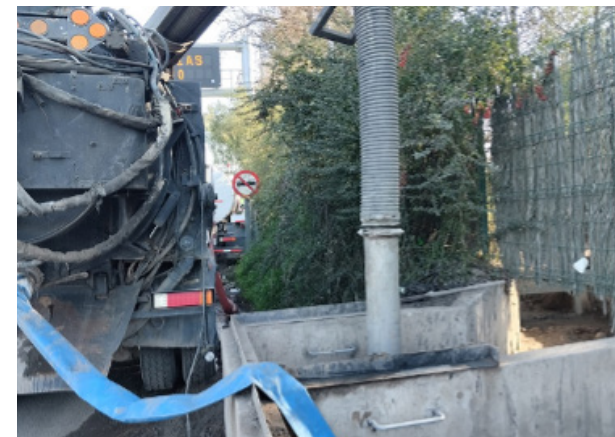
Limpieza sifón canal Seminario bajo calle Los Sauces, mediante camión Hidrojet y manual, comuna de Padre Hurtado.
