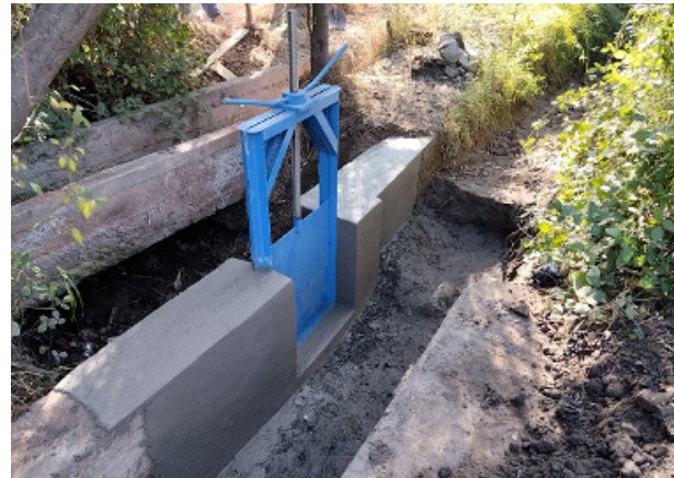
Reparación compuerta de distribución comunidad Santa Sofía, comuna Calera de Tango.
