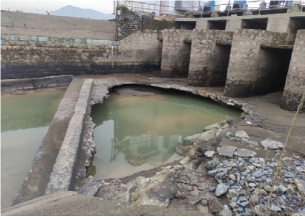
Reparación Losa Radier Admisión Canal Tronco
