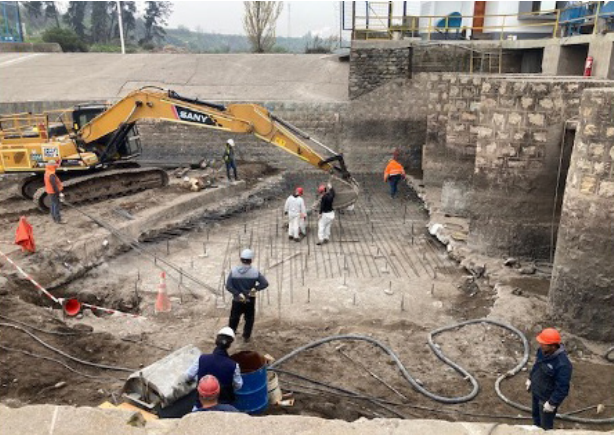
Reparación Losa Radier Admisión Canal Tronco
