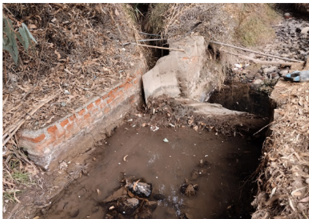
Canal Santa Cruz, reparación marco partidor M069, comuna Calera de Tango.
