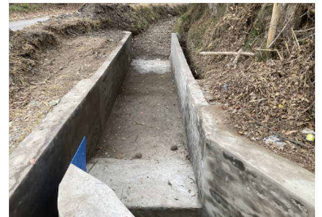
Reparación marco partidor M074 en canal Santa Cruz, comuna Calera de Tango.
