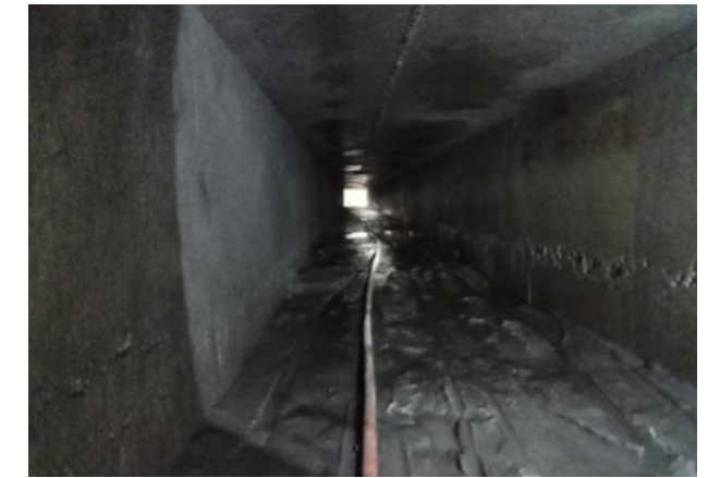
Limpieza sifón canal Flora Infante bajo Autopista Central, mediante camión Hidrojet, comuna San Bernardo.
