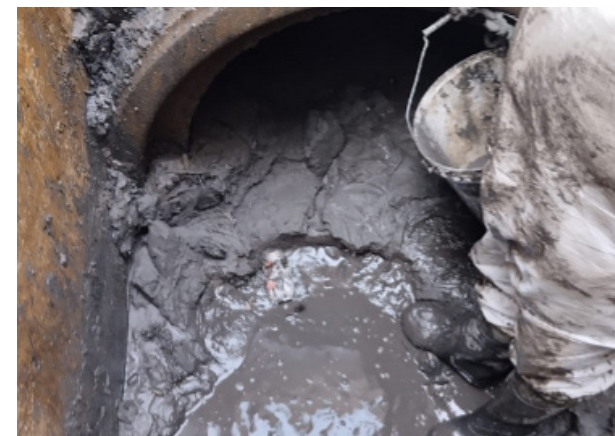
Limpieza sifones canal Seminario bajo vía de servicio ruta 78, mediante camión Hidrojet y manual, comuna de Padre Hurtado.
