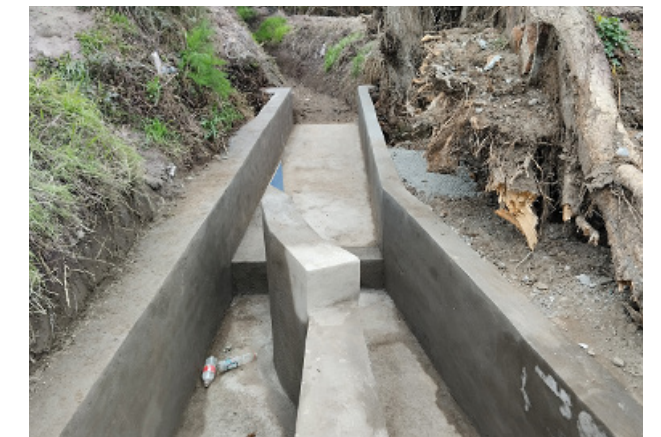
Reparación marco partidor interior Lo Moya-Nueva Independencia M078-2, comuna Calera de Tango.
