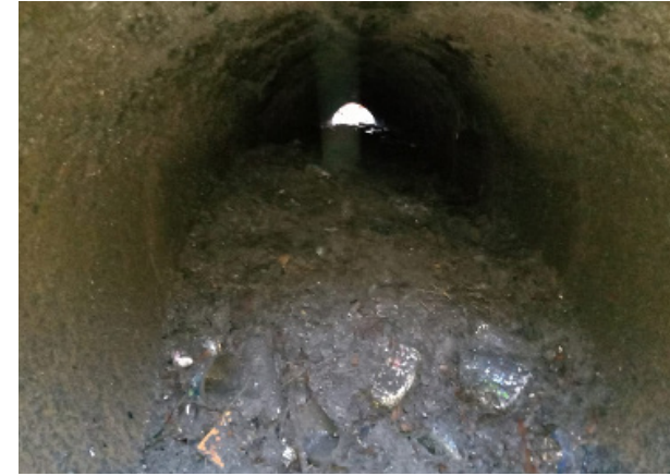
Limpieza sifón canal Seminario bajo calle Los Sauces, mediante camión Hidrojet y manual, comuna de Padre Hurtado.
