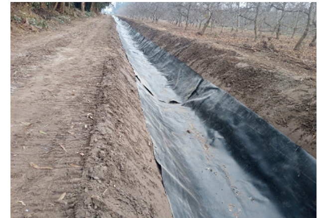
Canal Capilla Santa Cruz, mejoramiento 750 m de canal con geomembrana, comuna San Bernardo.
