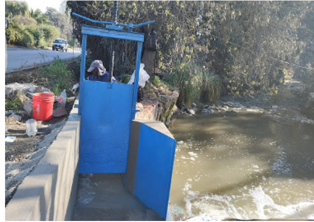
Reparación marco partidor M011 y compuerta en Canal Espejo, comuna San Bernardo.
