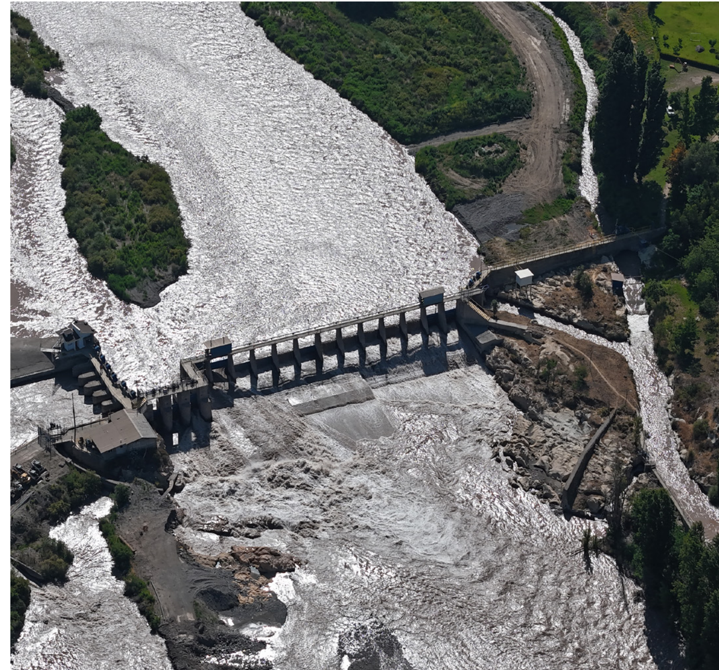
Bocatoma El Clarillo
