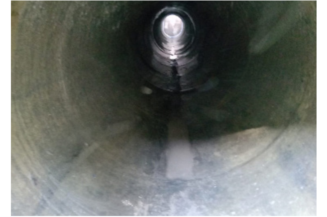
Limpieza sifón canal Seminario bajo calle Los Sauces, mediante camión Hidrojet y manual, comuna de Padre Hurtado.
