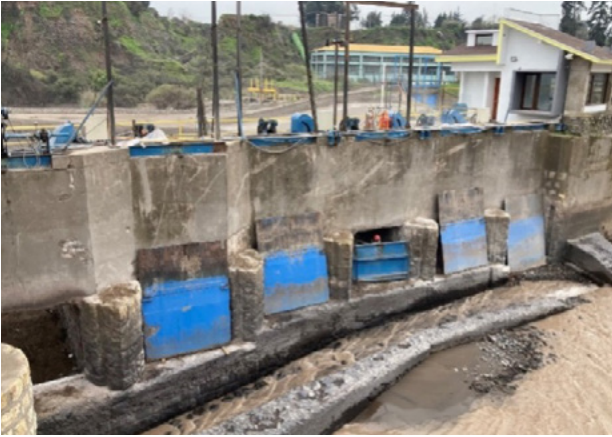
Reparación Compuertas Norte Bocatoma
