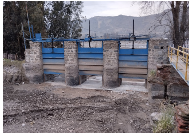
Mantenimiento compuertas descarga a río Maipo.
