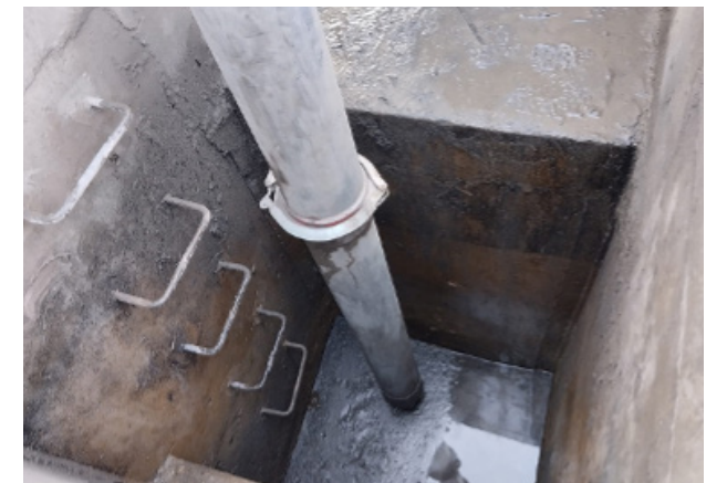
Limpieza sifón canal Seminario bajo calle Los Sauces, mediante camión Hidrojet y manual, comuna de Padre Hurtado.
