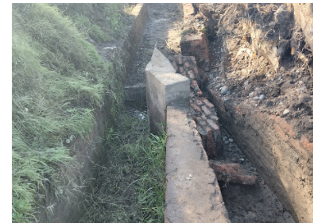
Reparación marco partidor interior Lo Moya-Nueva Independencia M078-2, comuna Calera de Tango.
