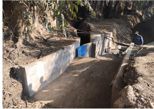
Reparación marco partidor M069 en canal Santa Cruz, comuna Calera de Tango.
