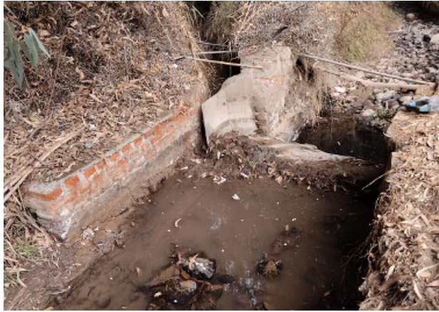
Reparación marco partidor M069 en canal Santa Cruz, comuna Calera de Tango.
