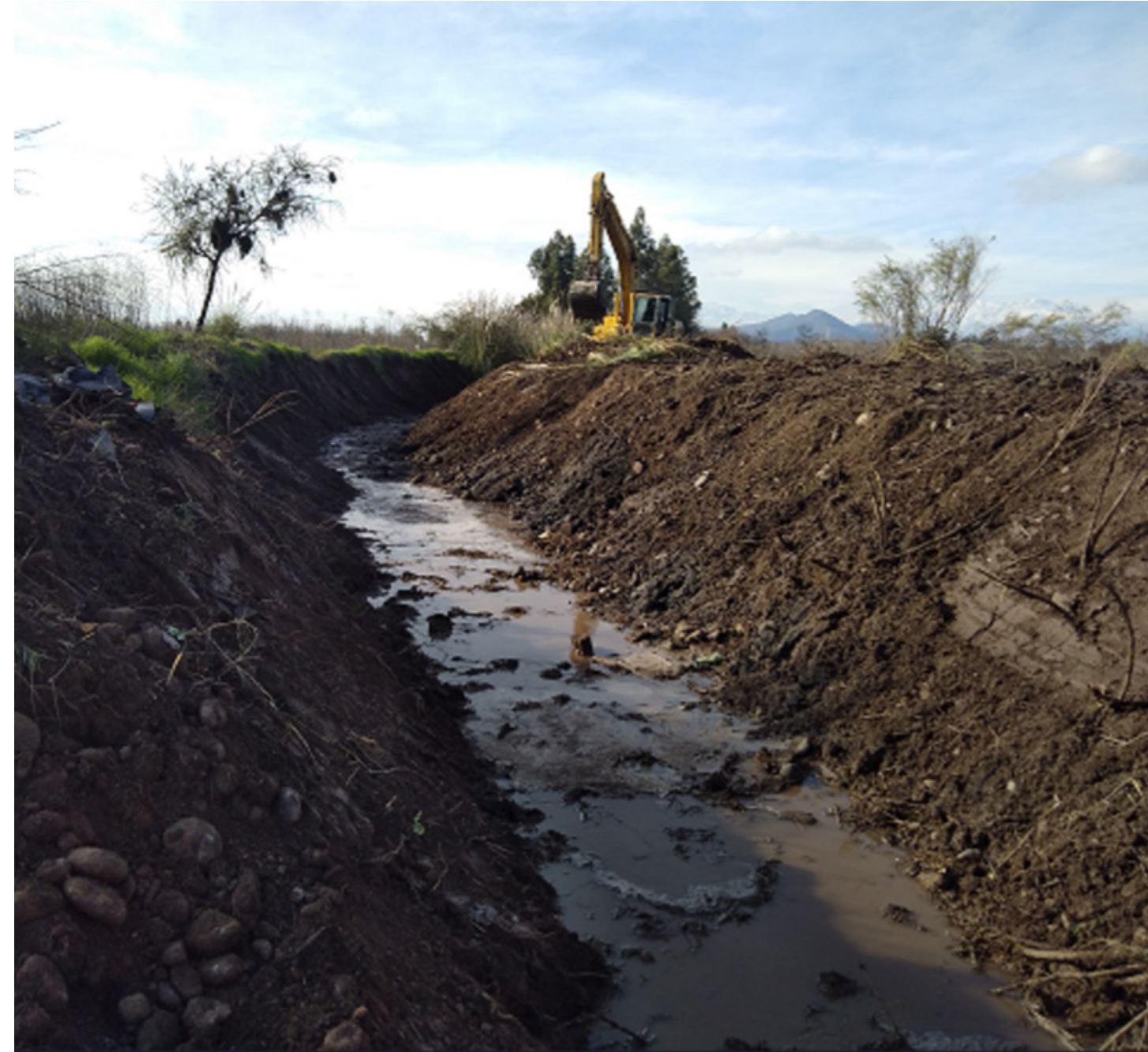
Canal Lonquén Oliveto, limpieza sector San Alfonso, comuna Calera de Tango.
