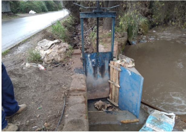
Reparación marco partidor M011 y compuerta en Canal Espejo, comuna San Bernardo.
