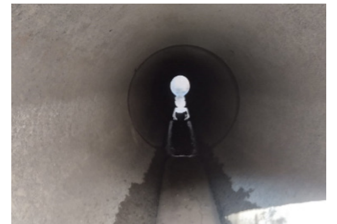
Limpieza sifones canal Seminario bajo vía de servicio ruta 78, mediante camión Hidrojet y manual, comuna de Padre Hurtado.
