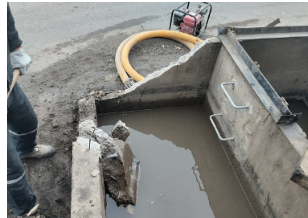
Reparación muros salida sifón canal Seminario sector Autopista del Sol, comuna Maipú.
