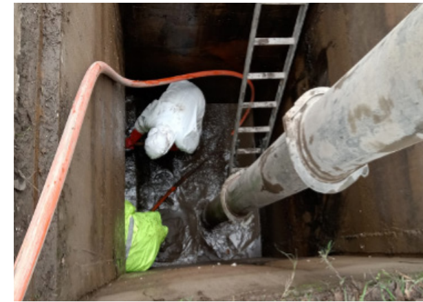
Limpieza sifón canal Flora Infante bajo Autopista Central, mediante camión Hidrojet, comuna San Bernardo.
