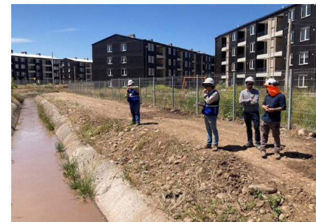
Modificación de Canales en Conjunto Habitacional San León Poniente 4885. San Bernardo.
