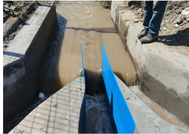
Reparación marco partididor El Trébol-La Ermita-La Rinconada M012-3B, comuna Calera de Tango.
