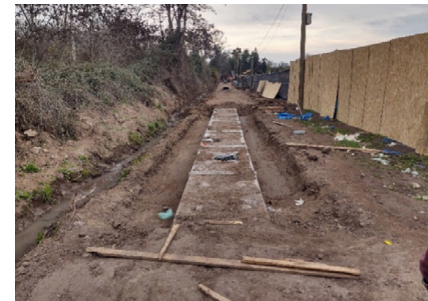
Modificación de Acueductos por Urbanización en Lote K. San Bernardo.
