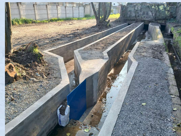
Reparación revestimiento de albañilería Etapa I (100 m), sector Meref, comuna Calera de Tango.
