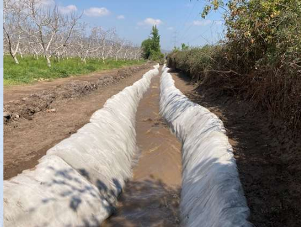
Revestimiento Derivado San José Etapa I Año 2024 – L : 120 m
