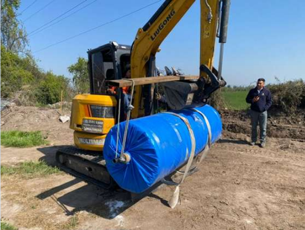
Formato rollo manta de hormigón: E : 10 mm - B : 2 m – L : 50 m
