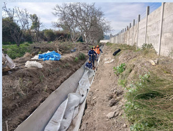
Revestimiento mediante Manta de Hormigón Derivado San José de Tango (300m), comuna Calera de Tango.
