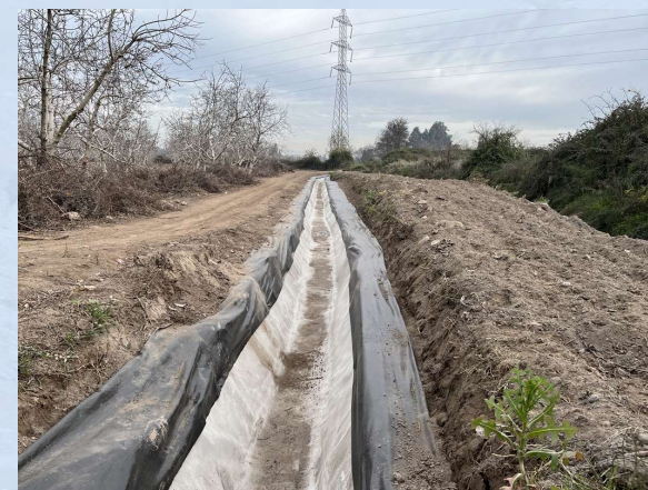
Revestimiento mediante Manta de Hormigón Derivado San José de Tango (300m), comuna Calera de Tango.
