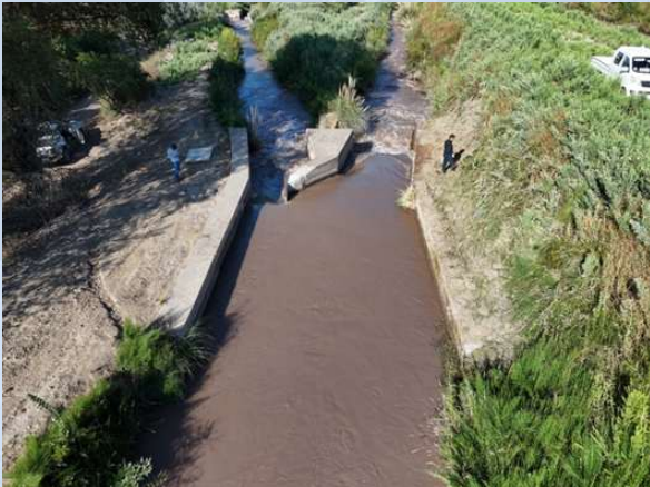
M063 – Canal Capilla Sta. Cruz – San Vicente
