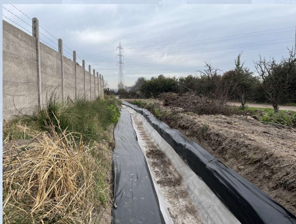
Revestimiento mediante Manta de Hormigón Derivado San José de Tango (300m), comuna Calera de Tango.
