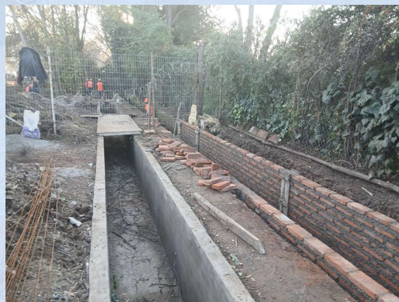
Reparación revestimiento de albañilería Etapa I (100 m), sector Meref, comuna Calera de Tango.
