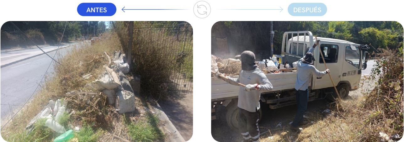
Canal La Picassa, retiro de basuras de marco partidor M012-2 sector camino Lonquén Norte, comuna San Bernardo.
