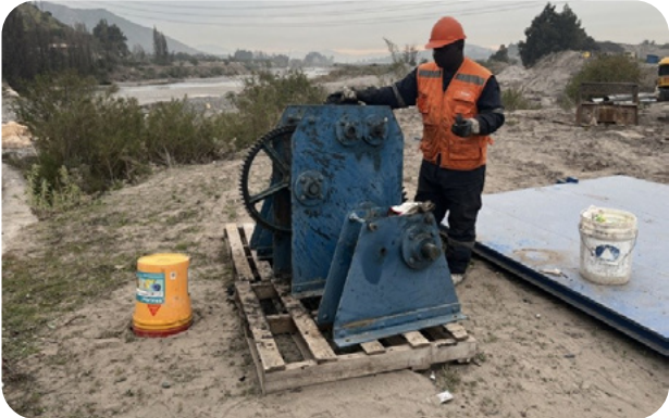
Mantenición sistema de engranaje y cremalleras de compuertas N°1 y N°2 sector Norte
