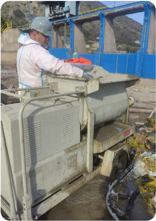
Inyecciones con lechada de cemento
