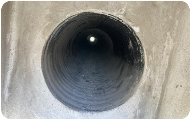
Situación proyectada tubo HDPE D:600 mm
