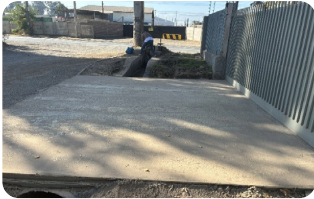
Acceso definitivo: tubo HDPE D:600 mm + losa H.A.
