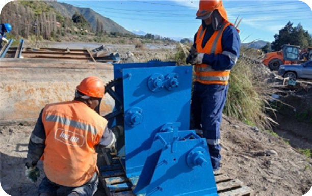
Mantenición sistema de engranaje y cremalleras de compuertas N°1 y N°2 sector Norte
