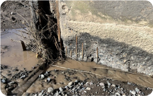
Reparación perfiles de guía y sello en compuerta frontal N°1
