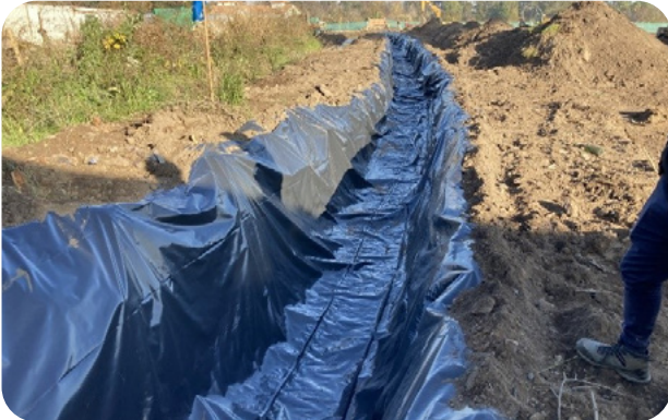
Proyecto en ejecución: canal bypass
