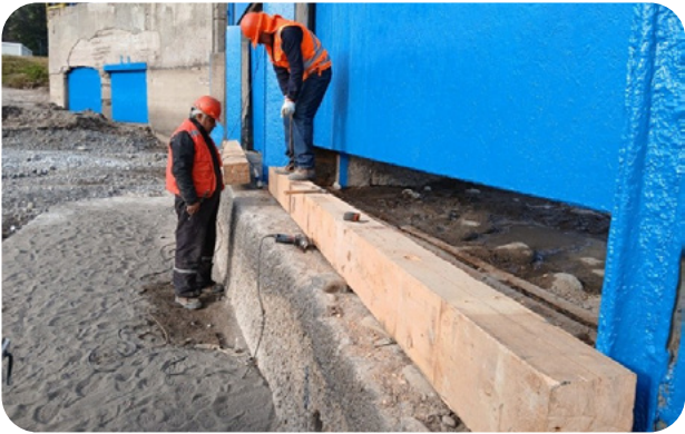
Reemplazo maderas de sello en compuertas N°5, 7, 10 y 11.
