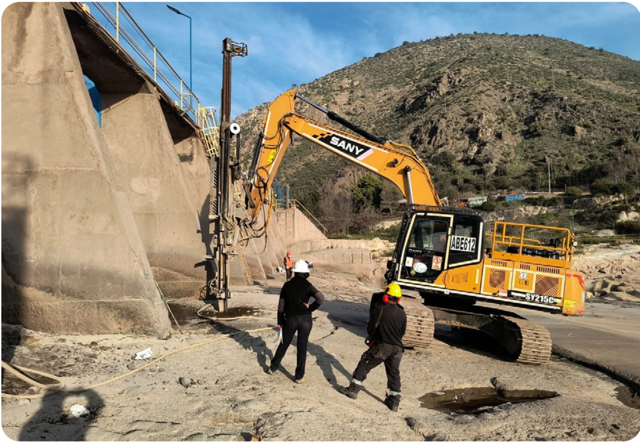
Perforaciones 2025 hacia aguas abajo
