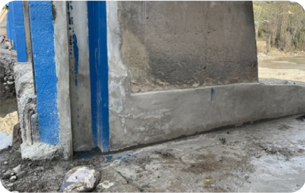
Reparación perfiles de guía y sello en compuerta frontal N°1
