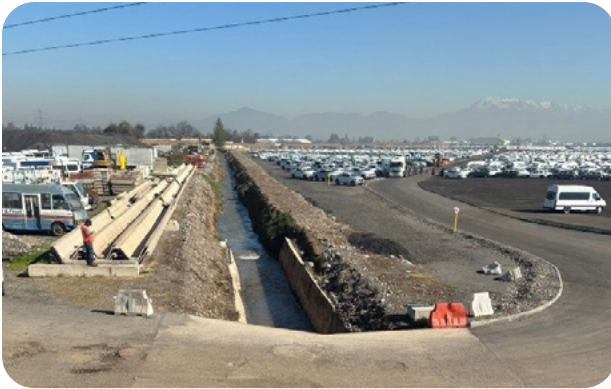
Puente 1 canal Santa Ana de Chena
