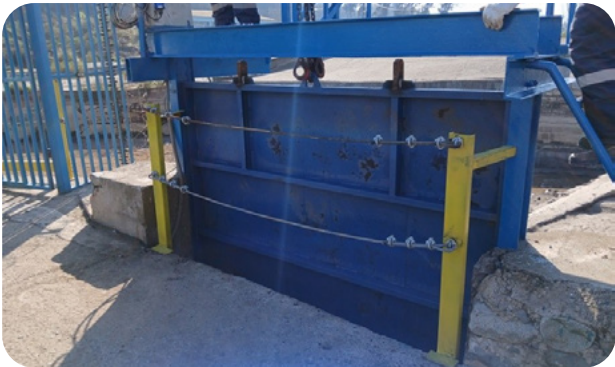
Reemplazo compuertas N°1 y N°2 sector Norte.
