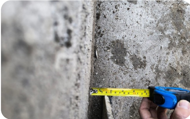
Marco partidor ejecutado
