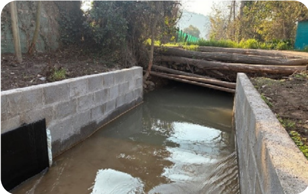
Marco partidor ejecutado
