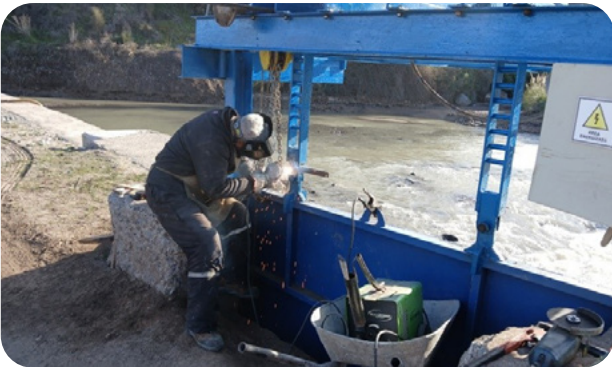
Reemplazo compuertas N°1 y N°2 sector Norte.
