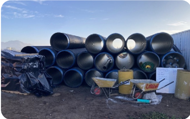
Solución: Tubo HDPE D:750 mm
