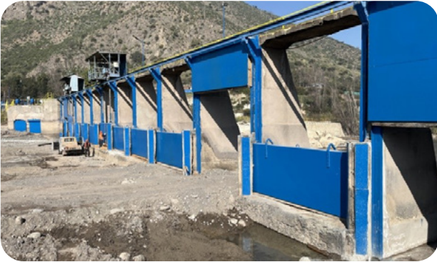
Mantenición 13 compuertas frontales.
