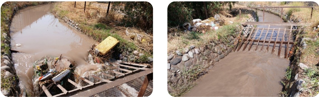
Reja contenedora de basura en canal Santa Cruz, retiro coordinado con Ilustre Municipalidad de Padre Hurtado.
