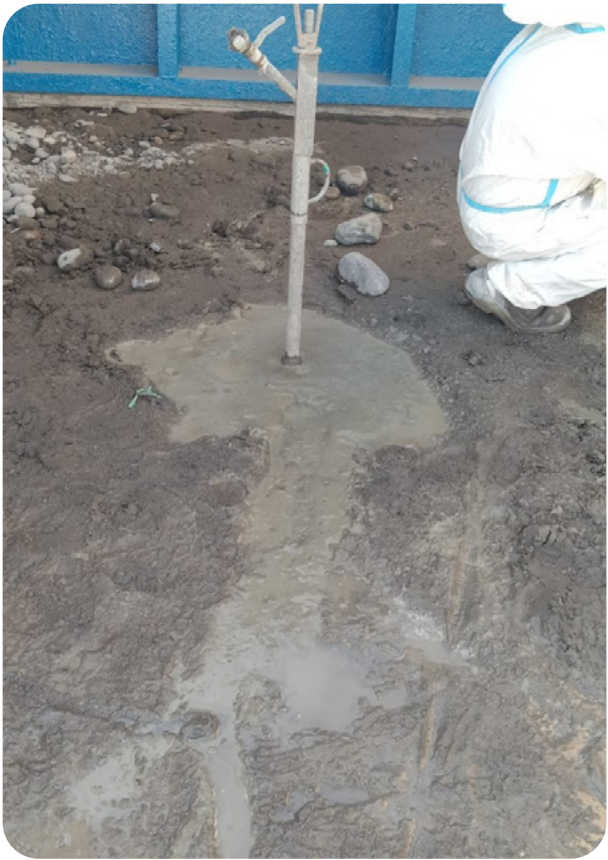
Inyecciones con lechada de cemento
