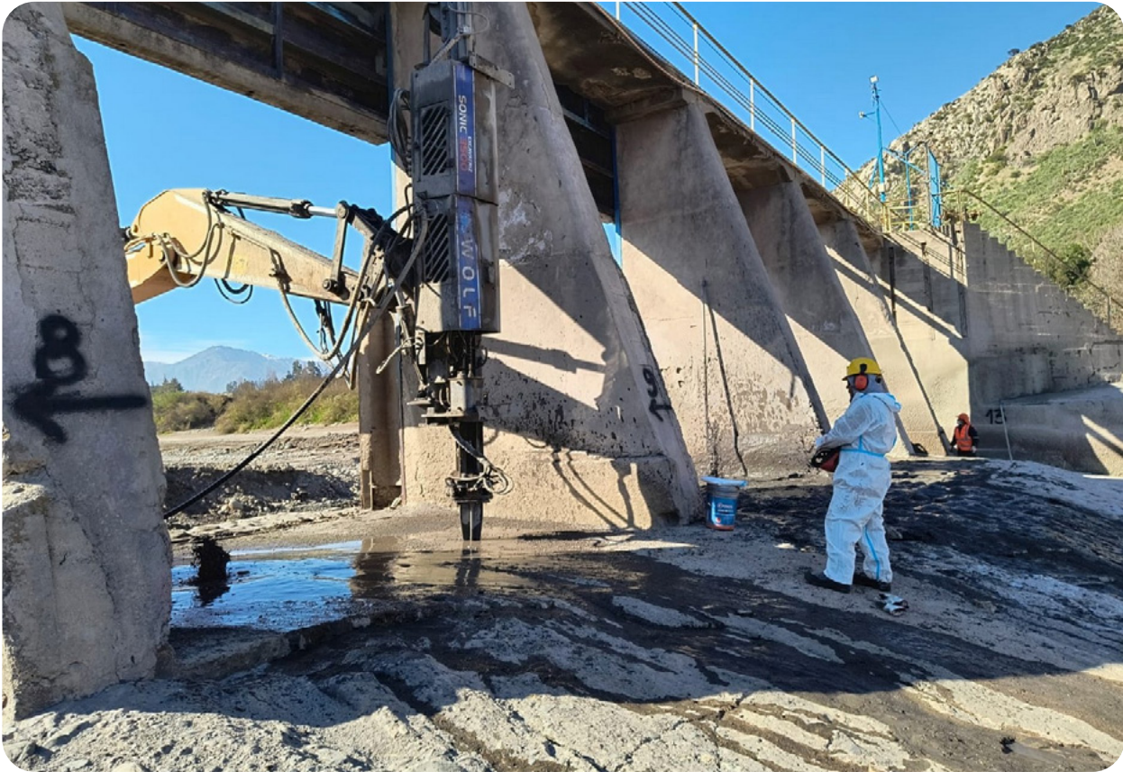
Perforaciones 2025 hacia aguas arriba
