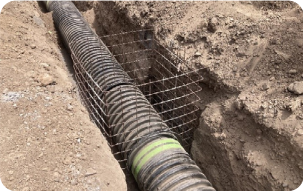
Solución canal 2: Tubo HDPE D:600 mm
