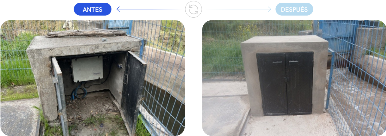
Reparación radier y gabinete telemetría canal Santa Cruz en M066, comuna San Bernardo.
