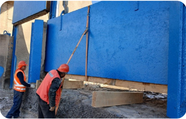
Reemplazo maderas de sello en compuertas N°5, 7, 10 y 11.
