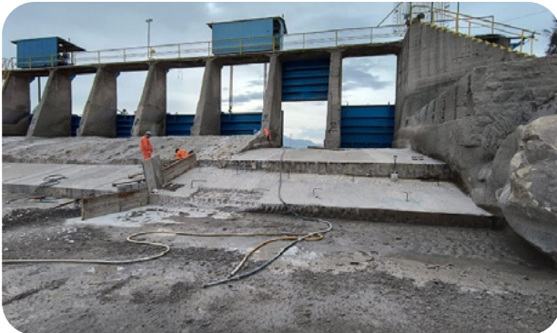
Rampa hormigonada vista desde el norte
