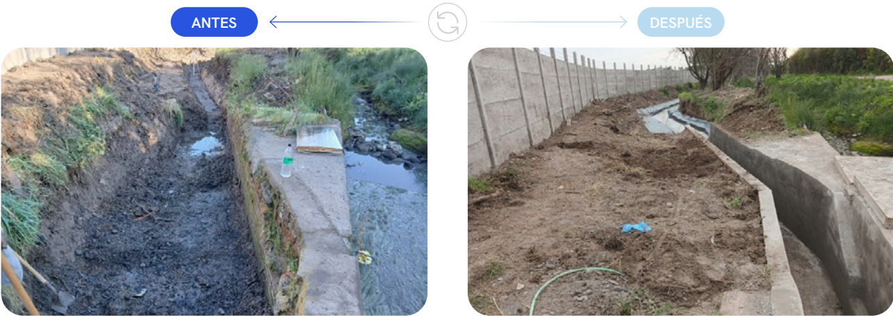
Revestimiento albañilería tramo inicial Derivado San José de Tango, comuna Calera de Tango.
