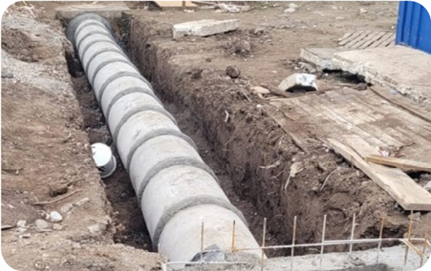
Solución canal 1: Tubo hormigón simple D:600 mm
