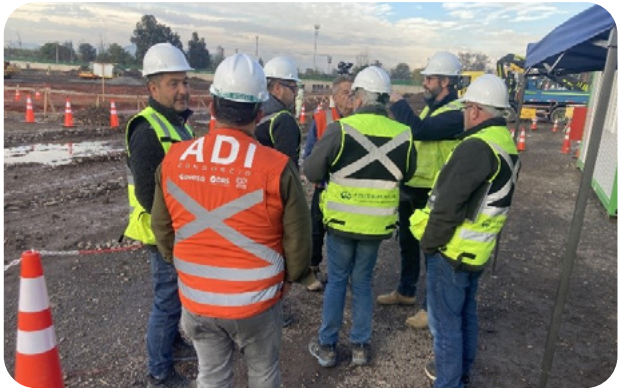
Inspección Técnica de Obras
